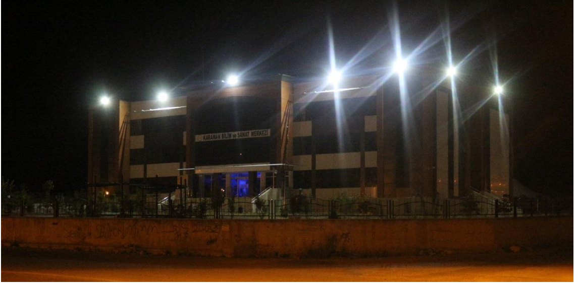
F7 noktası Karaman Bilim Sanat Merkezi aydınlatma çevre evleri vuruyor.
