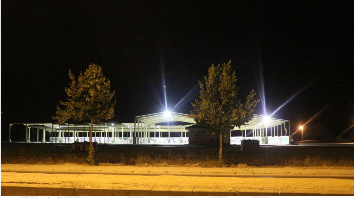
D6 noktası kullanılmayan Çarşamba pazarı gece aydınlatması
