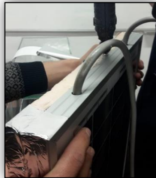
Şekil 3.4. Geliştirilen serpantinli su soğutmalı panelin (SRP) imalatı ve montajı.
