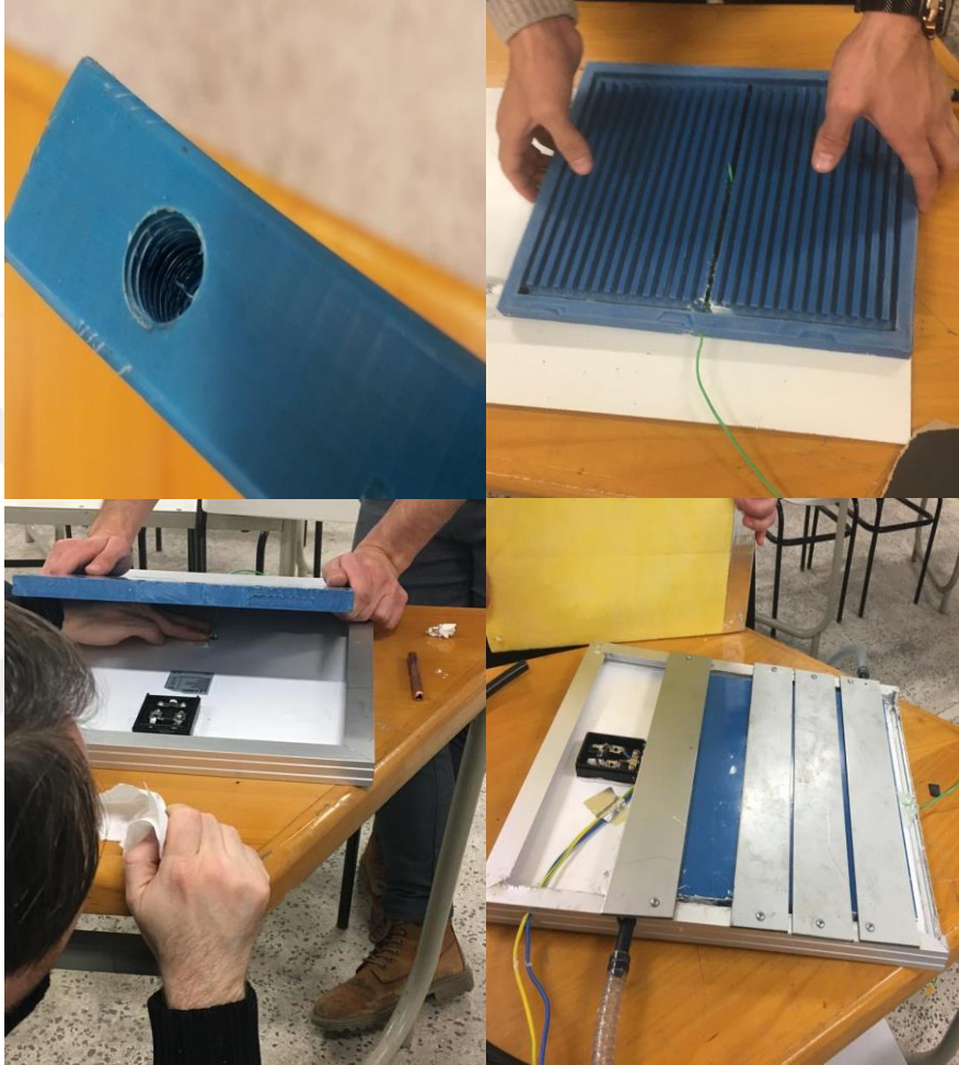
Şekil 3.3. Su akışı için geliştirilen kanallı panel (SKP) imalatı ve montajı.
