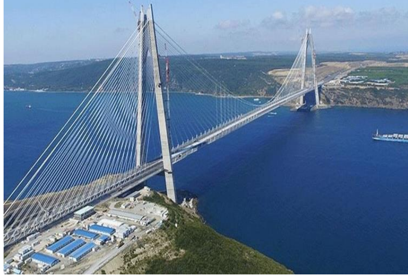
Şekil 2.3. Yavuz Sultan Selim Köprüsü.
