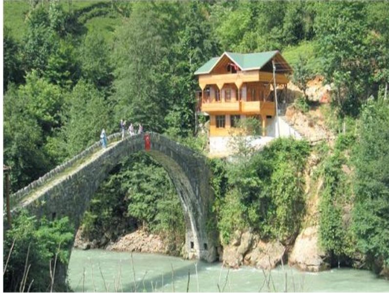
Şekil 3.1. Akarsu yaya köprüsü (Rize).
