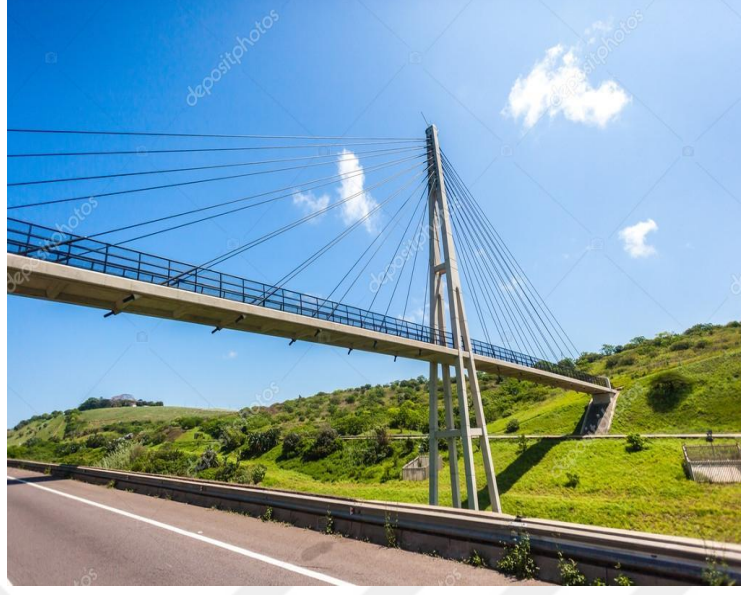
Şekil 3.22. Kablolu yaya köprüsü.
