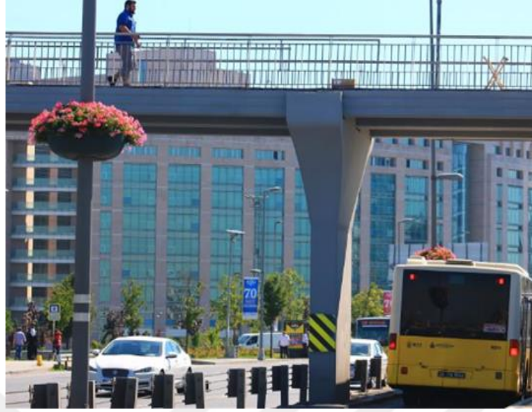
Şekil 3.8. Betonarme yaya köprüsü.
