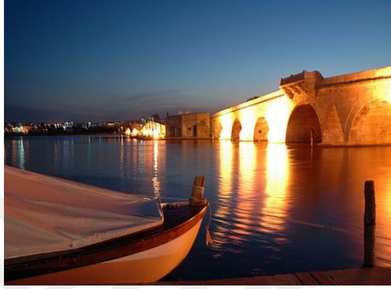
Şekil 3.5. Silivri Çayı Köprüsü .
