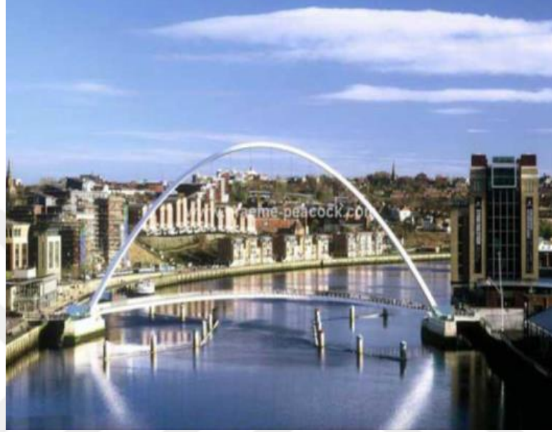
Şekil 3.2. Gateshead bridge çelik akarsu yaya köprüsü [9].
