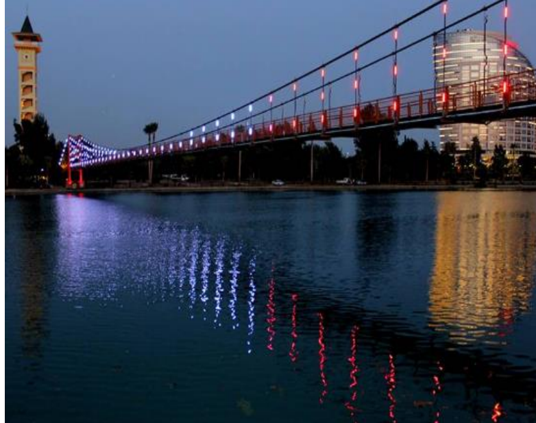
Şekil 3.19. Adana Sinan Paşa asma köprü.
