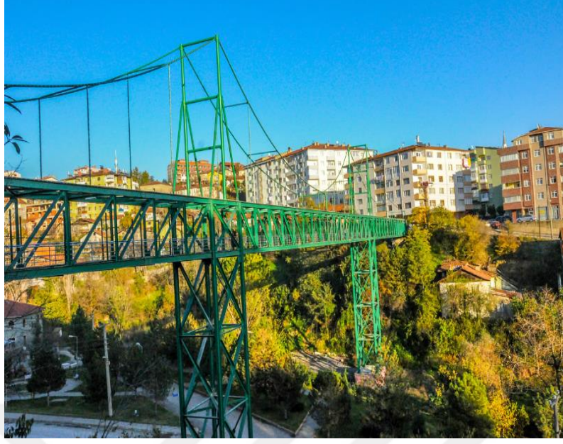
Şekil 3.10. Çelik yaya köprüsü (Karabük) [19].
