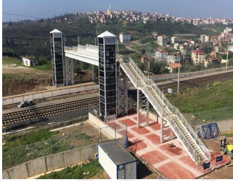
Şekil 3.3. Gebze demiryolu yaya köprüsü [18].
