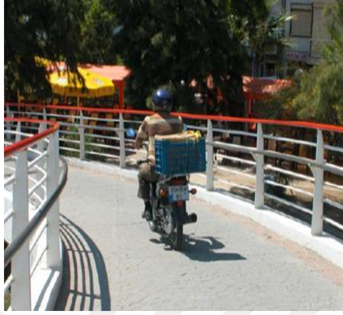
Şekil 3.25. Güzelyalı yaya köprüsü (İzmir) [8].
