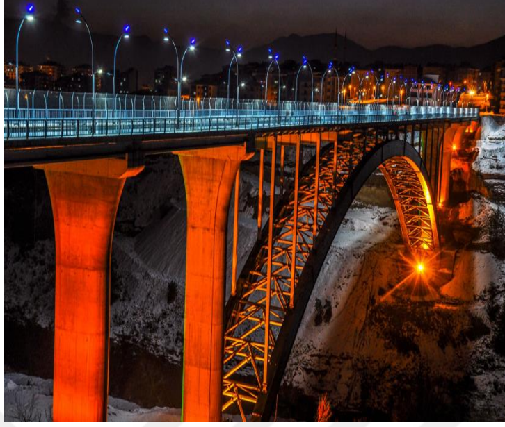
Şekil 3.11. Kanyon Köprüsü (Karabük) [19].
