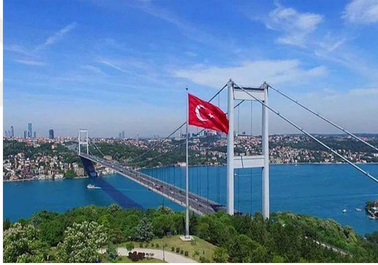
Şekil 2.2. Fatih Sultan Mehmet Köprüsü .
