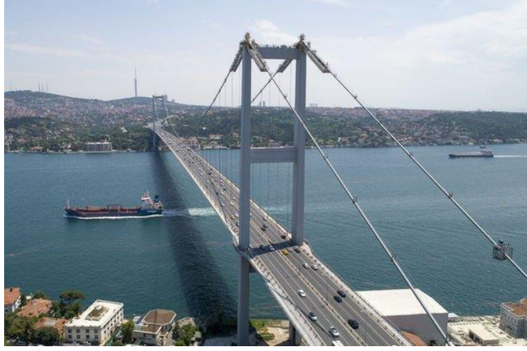
Şekil 2.1. 15 Temmuz Şehitler Köprüsü (Boğaziçi Köprüsü).
