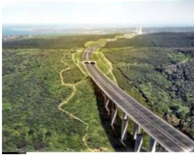
Şekil 2.8. Kuzey Marmara otoyolu ekolojik köprüsü [15].
