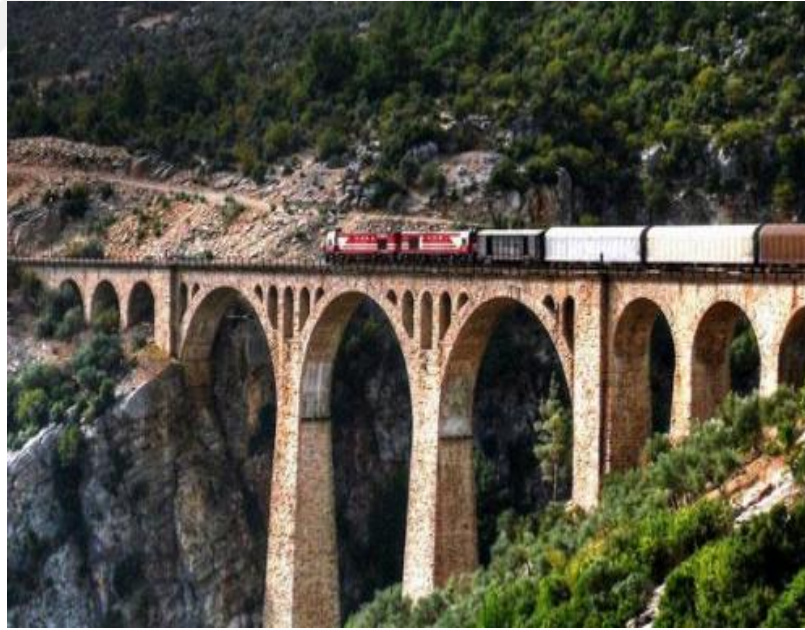
Şekil 2.6. Adana Varda demiryolu Köprüsü.
