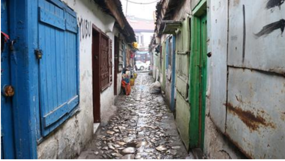
Şekil 2.8. Çorum Dikiciler Arastası sokak görünümü [20, 21].
