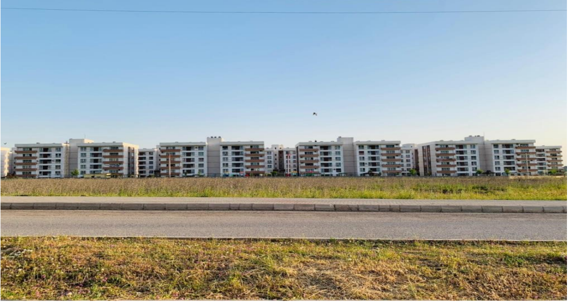
Fotoğraf 30: Silopi’de Yapılmakta Olan TOKİ’lerden Bir Görünüm
