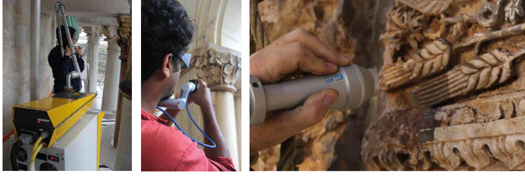
Şekil 2.37. Lazer yöntemi ile temizlik uygulamaları (Zanini vd, 2019).
