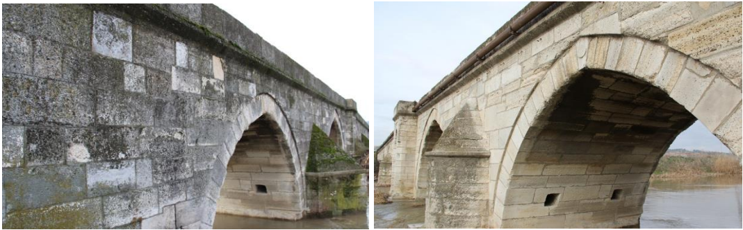
Şekil 2.9. Bir ince yonu taş duvar örgüsü: Lüleburgaz Sokullu Mehmed Paşa Köprüsü (İnternet, 3).
