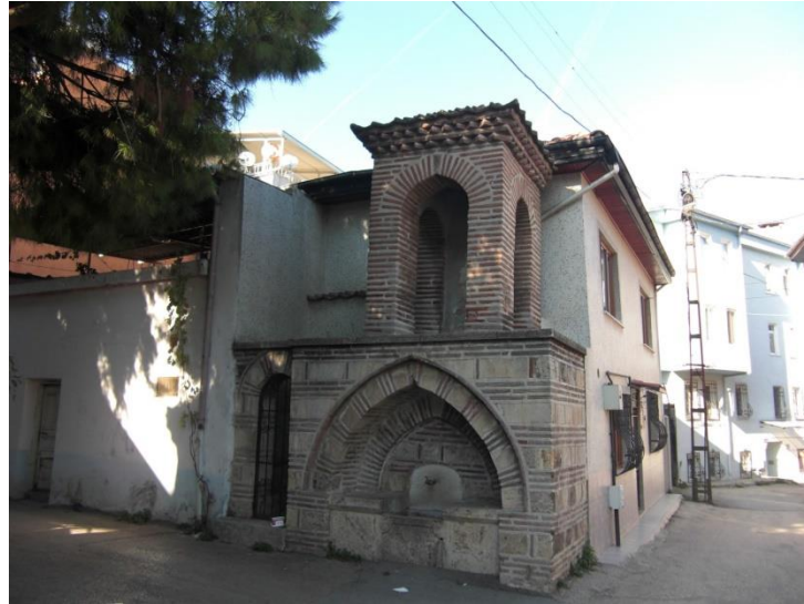
Şekil 4.14. Veled-i Yaniç Camii minare ve çeşmesi.
