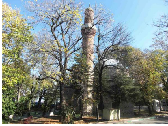
Şekil 5.17. İmaret-i İsabey Camii genel görünümü.
