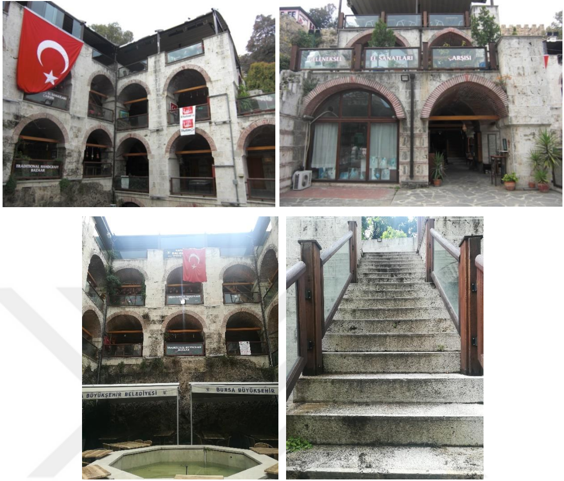
Şekil 5.31. Cephe üzerindeki kararmalar ve bitki oluşumları.
