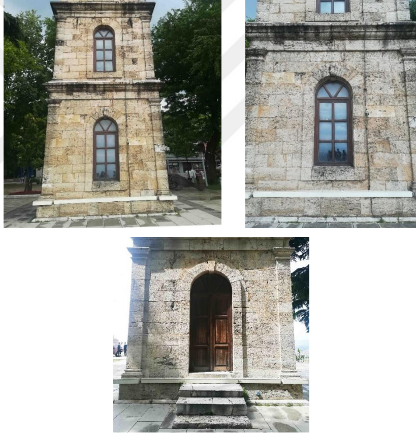
Şekil 4.41. Cephe yüzeyindeki kirlilikler.
