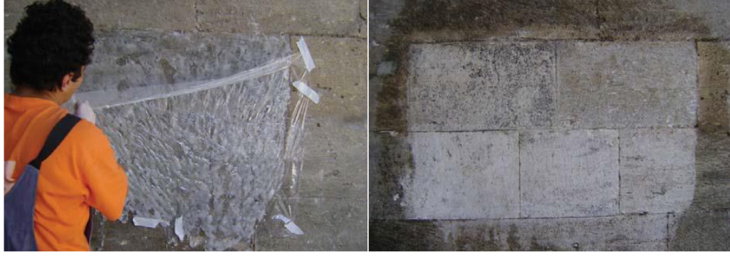
Şekil 2.33. Küfeki taş yüzeyde kimyasal temizlik test uygulaması (Güleç, 2014).
