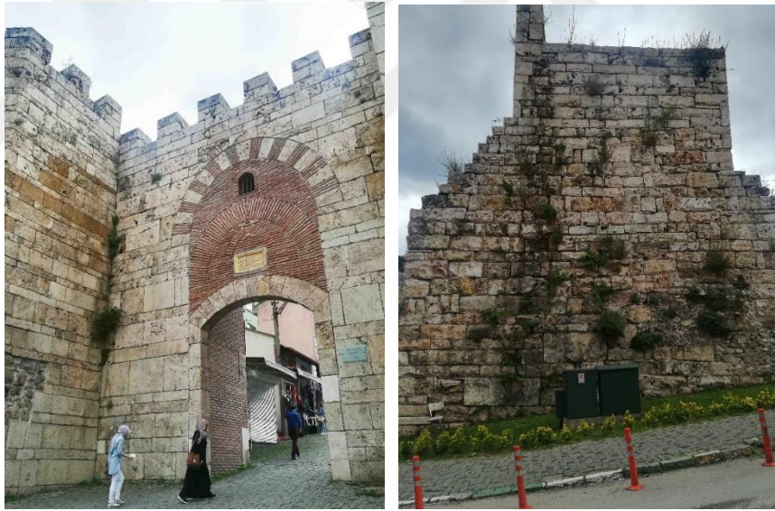
Şekil 5.6. Saltanat Kapı üzerindeki kararmalar ve bitki oluşumları.
