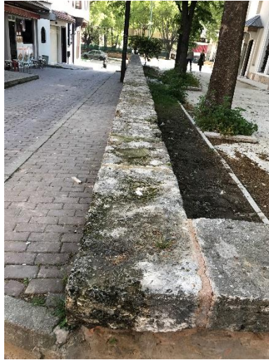
Şekil 4.11. Mikro kumlama uygulaması öncesi harpuştanın görünümü, (BVBM fotoğraf arşivi).
