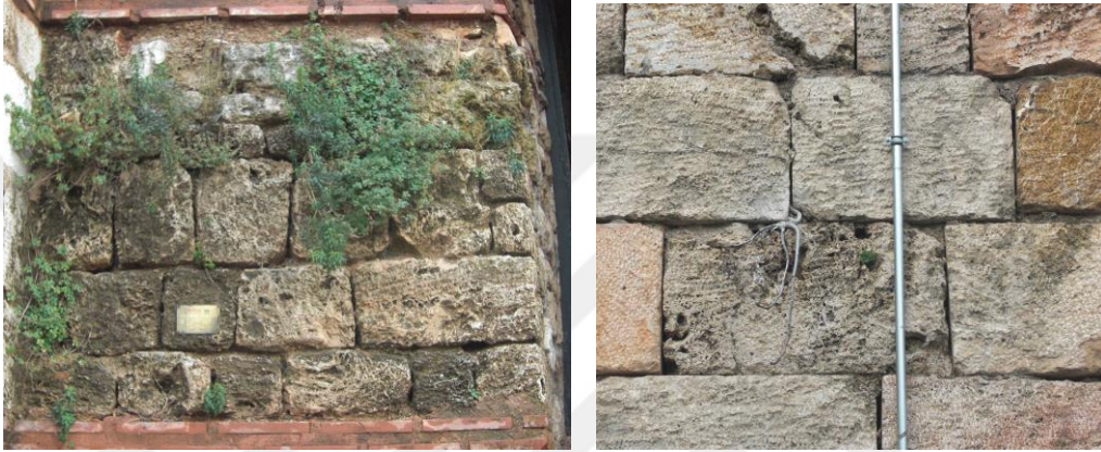
Şekil 5.8. Fetih Kapı üzerindeki otsu ve odunsu bitki oluşumları.
