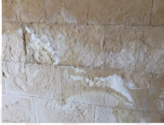
Şekil 2.16. Çiçeklenme örneği: İshak Paşa Sarayı, Ağrı (Artık vd, 2018).
