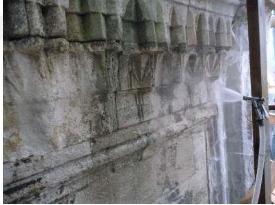
Şekil 2.35. Atomize su ile temizlik uygulaması (Anonim, 2015).
