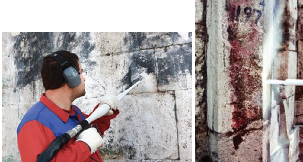
Şekil 2.36. Kuru buz yöntemi ile temizlik uygulaması (Ersen, 2013).
