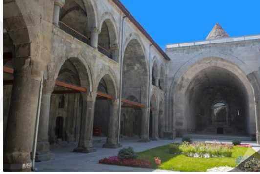
Şekil 2.11. Kesme taş duvar yapı örneği: Erzurum Çifte Minareli Medrese (İnternet,4).
