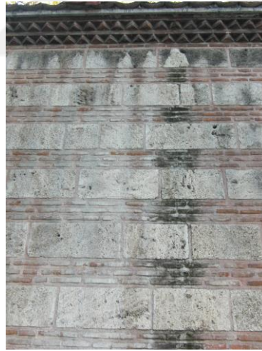
Şekil 5.29. Oluk hasarından dolayı çatıdan duvar yüzeyine akan suyun neden olduğu yosun oluşumu.
