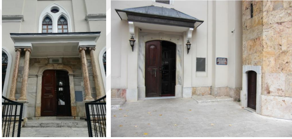
Şekil 4.10. Mermer yüzeylere AB 57, minare ve cami duvarı etek kısmına mikro kumlama uygulaması sonrası görünüm.
