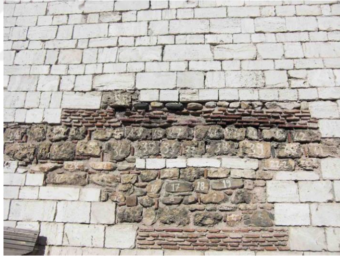
Şekil 3.18. Bursa Kalesi surları üzerindeki özgün ve yeni üretim malzemeler.
