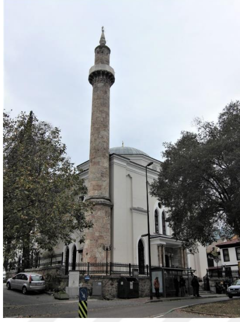
Şekil 4.3. Şehadet Camii genel görünümü.
