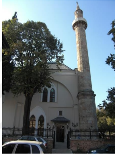
Şekil 4.5. Şahadet Camii minaresi.
