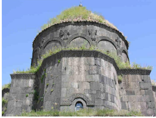
Şekil 2.1. Bazalt taşının yapıda kullanımına örnek: Kars Kümbet Camii (Sağır, 2008).
