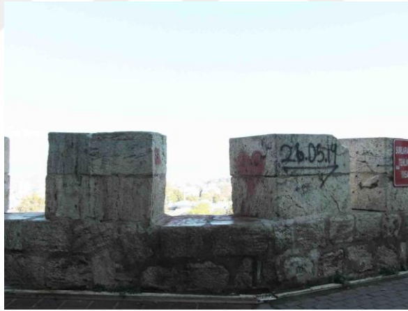
Şekil 5.4. Spreyci boya kirlilikleri ve metal elemanın surlara sabitlenmesi.
