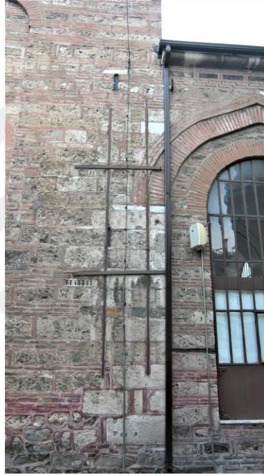
Şekil 5.16. Üftade Camii beden duvarı güçlendirme demirleri.
