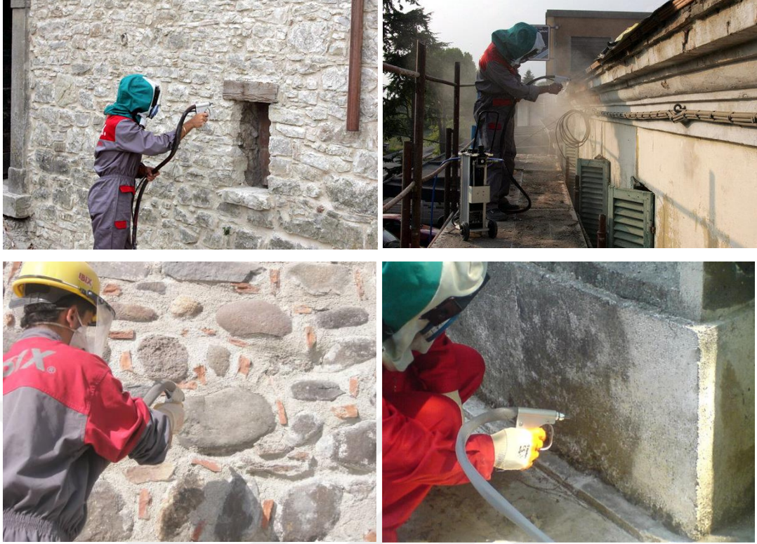
Şekil 2.28. Mikro kumlama uygulamaları (İnternet, 8).
