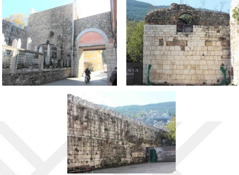
Şekil 5.12. Yer Kapı ve yakın surlarında tespit edilen cephe kirlilikleri.
