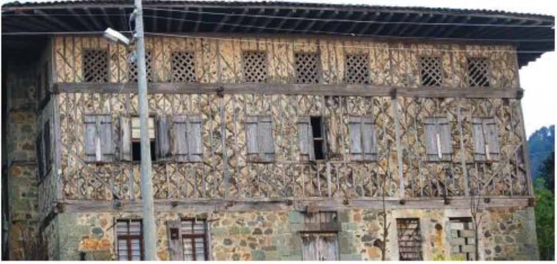
Şekil 3.31 Köşe dikmeleri payandalarla desteklenmiş bir ahşap yapıdan görünüm (Güneş, 2014).
