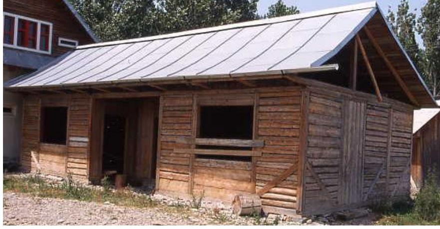
Şekil 3.8. Ahşap dolma duvar (Taraba) örneği (Arun, 2012).
