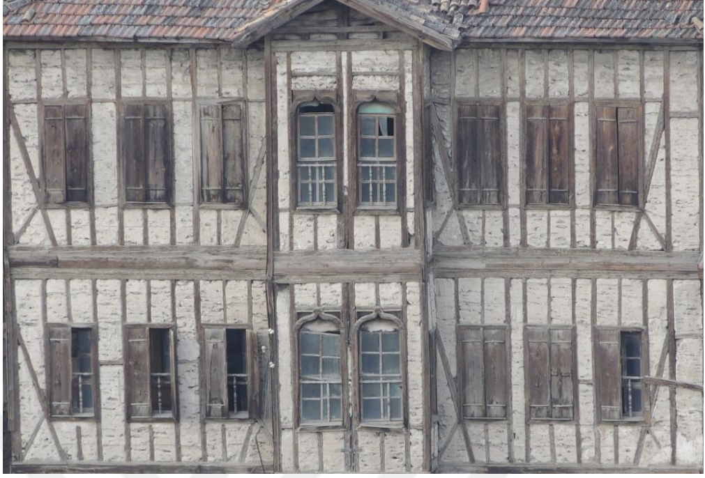
Şekil 3.24. Hımiş duvarlı ahşap yapı örneği (Güneş, 2014).
