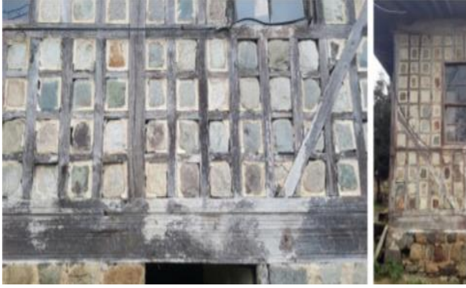
Şekil 3.33. Göz dolma duvar sistemli ahşap yapı örneği (Tunçkol, 2018).
