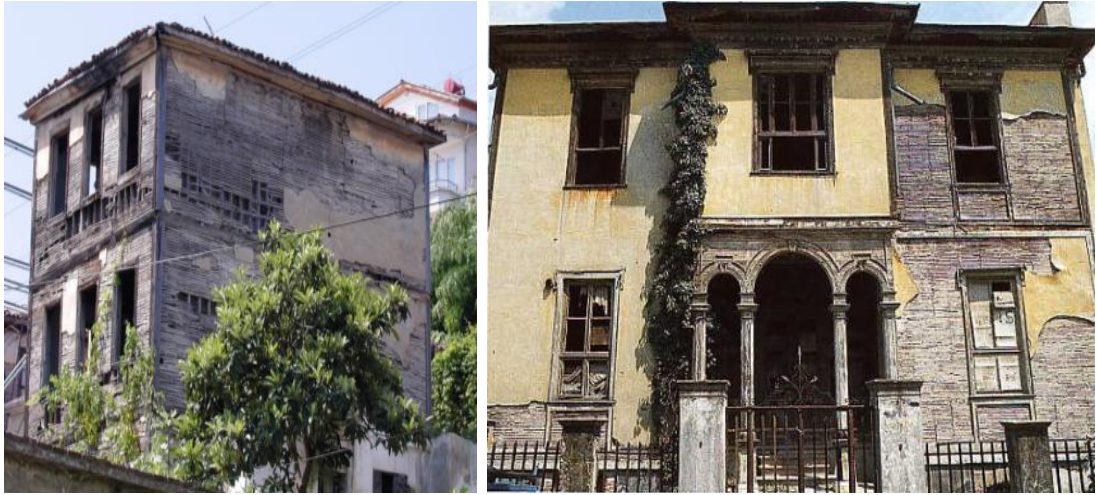
Şekil 3.16. Bağdadi tekniğiyle yapılmış ahşap yapı örnekleri (Güney, 2016).
