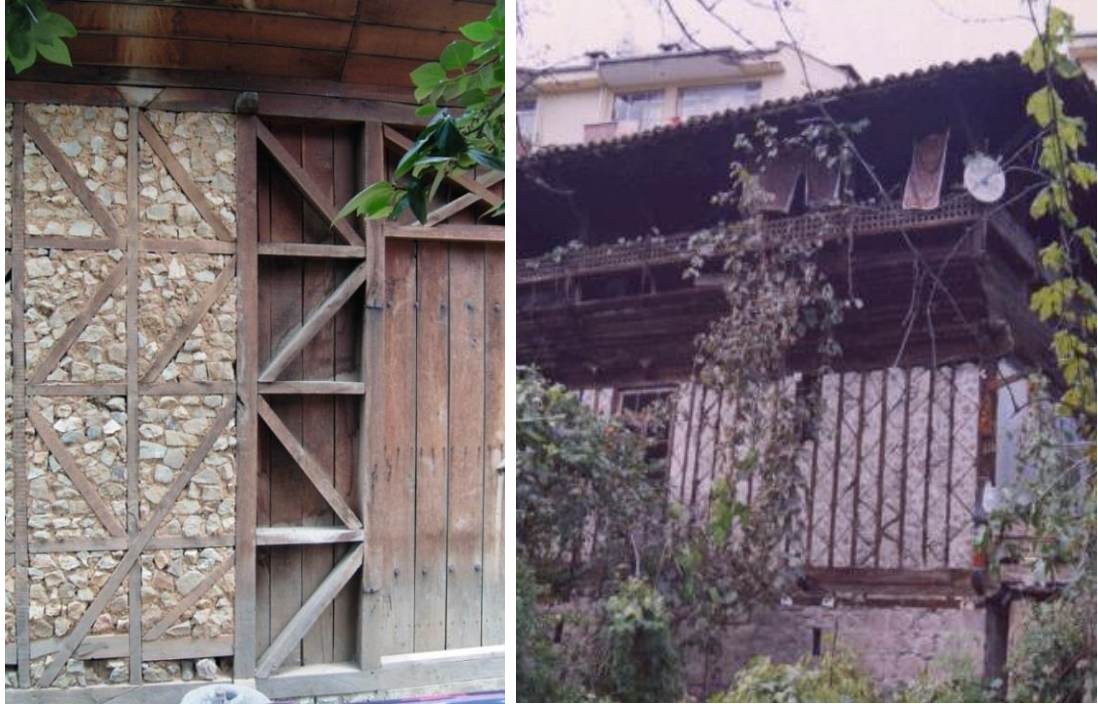
Şekil 3.28. Ahşap yapılarda muska dolma duvar örneği (Güneş, 2014).
