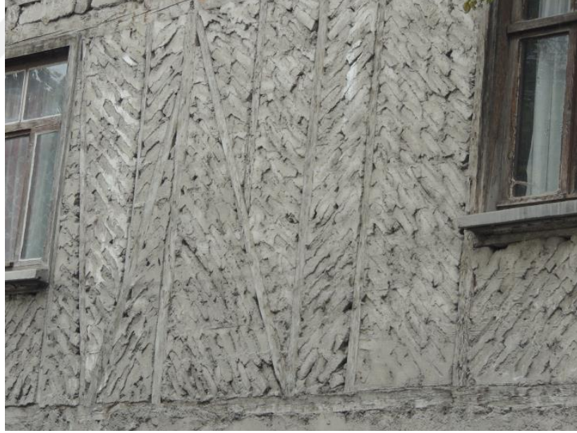
Şekil 3.25. Balıksırtı tuğla dolgulu duvar örneği (Güneş, 2014).
