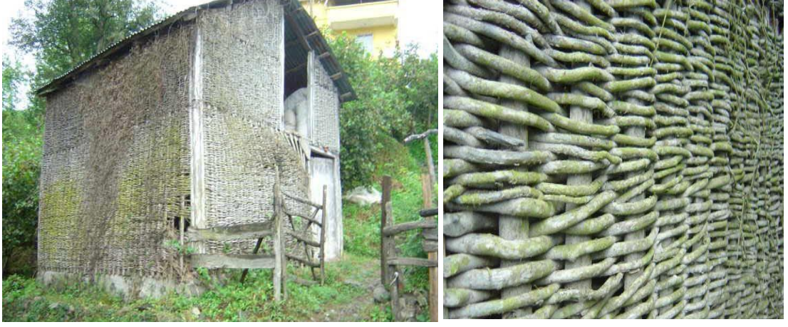
Şekil 3.20. Çöten duvar ve bu teknikle yapılmış ahşap yapı örneği (Güneş, 2014).
