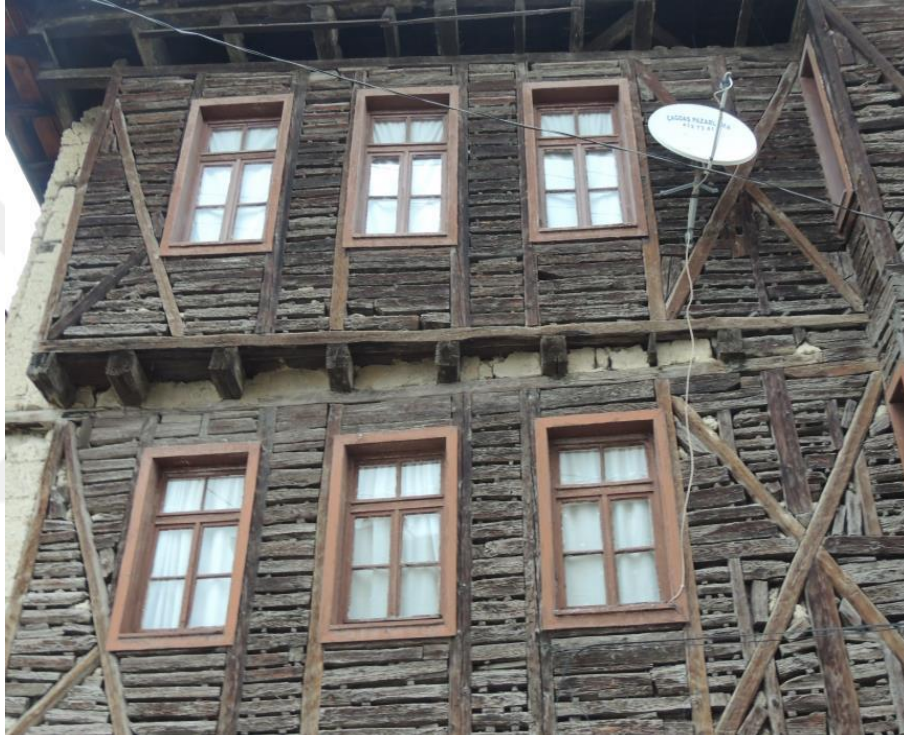
Şekil 3.22. Dizeme tekniğiyle yapılmış ahşap yapı örneği (Güneş, 2014).
