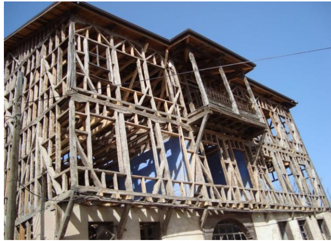
Şekil 3.14. Bilecik Osmaneli’nde Ahşap çatki örneği (Güneş, 2014).
