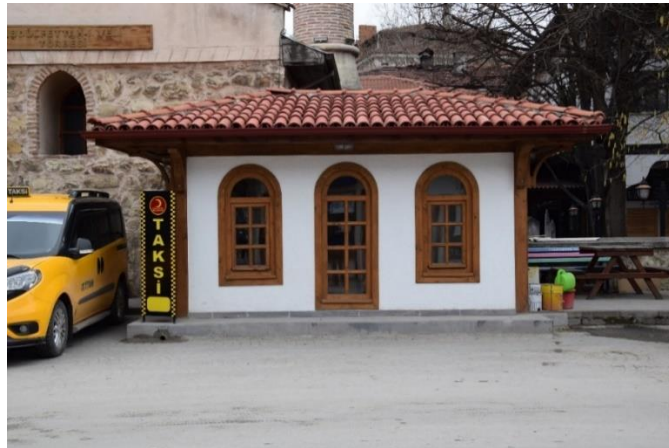
Foto. 80 Cebrail Mahallesi, Taksi Durağı, 2019 (Kişisel Arşiv)
