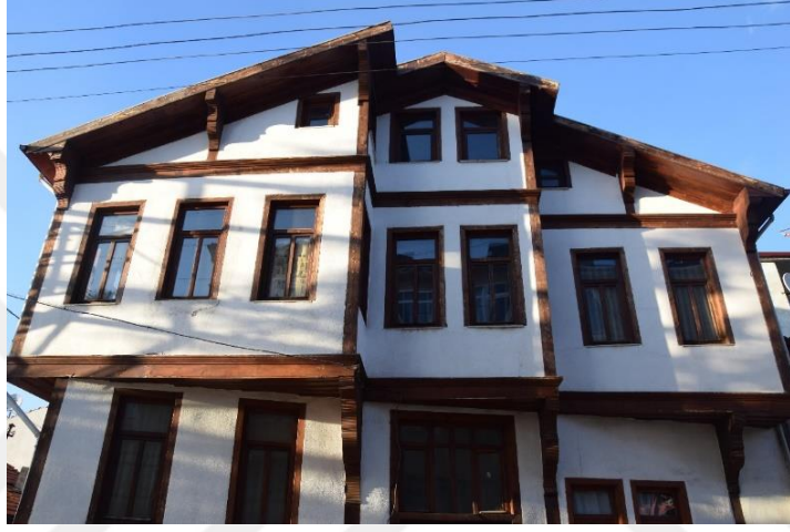
Foto. 9 Çatı Eğimi Kısımda Yapılan Çatı Odası, Cebrail Mahallesi, Kırkçeşme Caddesi, No: 67, 19.yüzyıl (Kişisel Arşiv)
