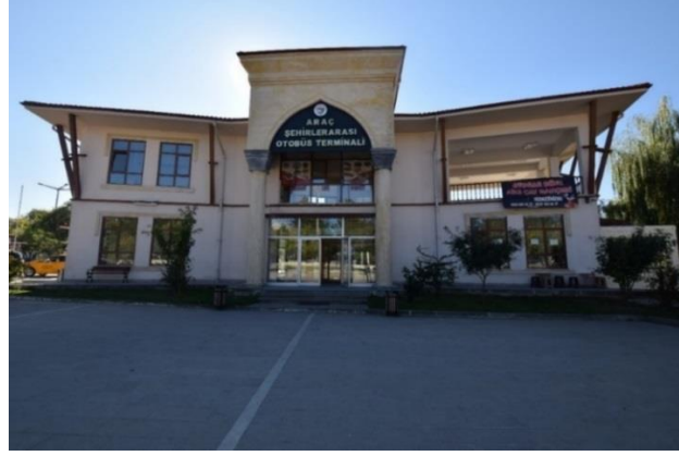
Foto. 108 Araç İlçesi Otogar Binası, 2017 (Kişisel Arşiv)
