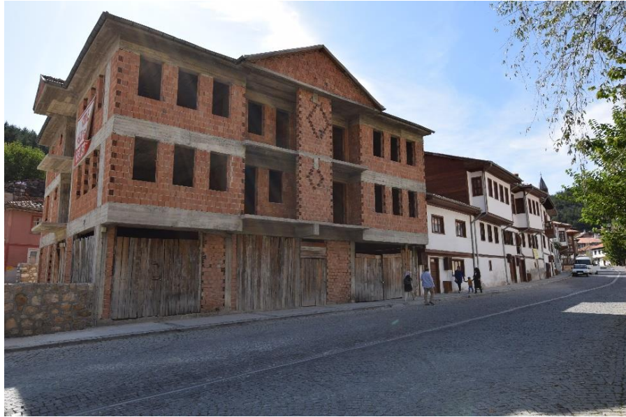
Foto. 124 Hisarardı Mahallesi, Şeyh Şaban-ı Veli Caddesi, Geleneksel Dokuya Uygun Kaplama Yapılan Yapılar (Kişisel Arşiv)
