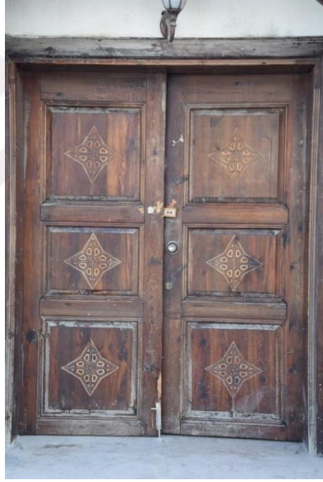
Foto. 112 Kuzeykent Mahallesi, Kazım Karabekir Caddesi, Ufo İş Merkezi, Kapı Kanadı (Kişisel Arşiv)
