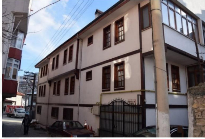
Foto. 36 Kırıkoğlu Apartmanı, Arka Cephe (Kişisel Arşiv)
