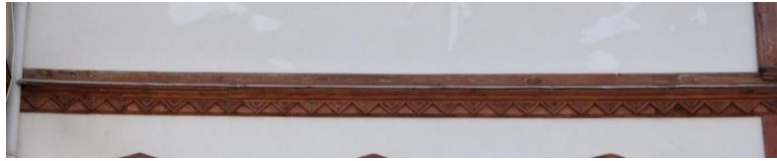
Foto. 24 Hatice Topaloğlu Binası, 2000, Ahşap Şeritler İçinde Bulunan Üçgen Süslemeler
