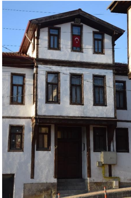
Foto. 10 Çatıdan Bağımsız Olarak Oluşturulan Çatı Odası, Cebrail Mahallesi, Kırkçeşme Caddesi, No:39, 19.yüzyıl (Kişisel Arşiv)
