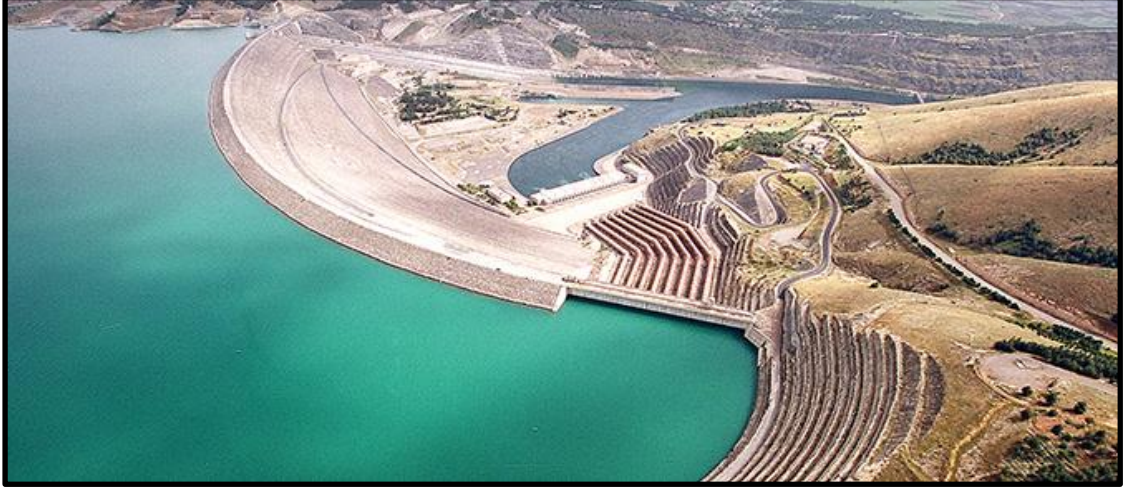
Resim 3. GAP Projesi kapsamında yapılan baraj
