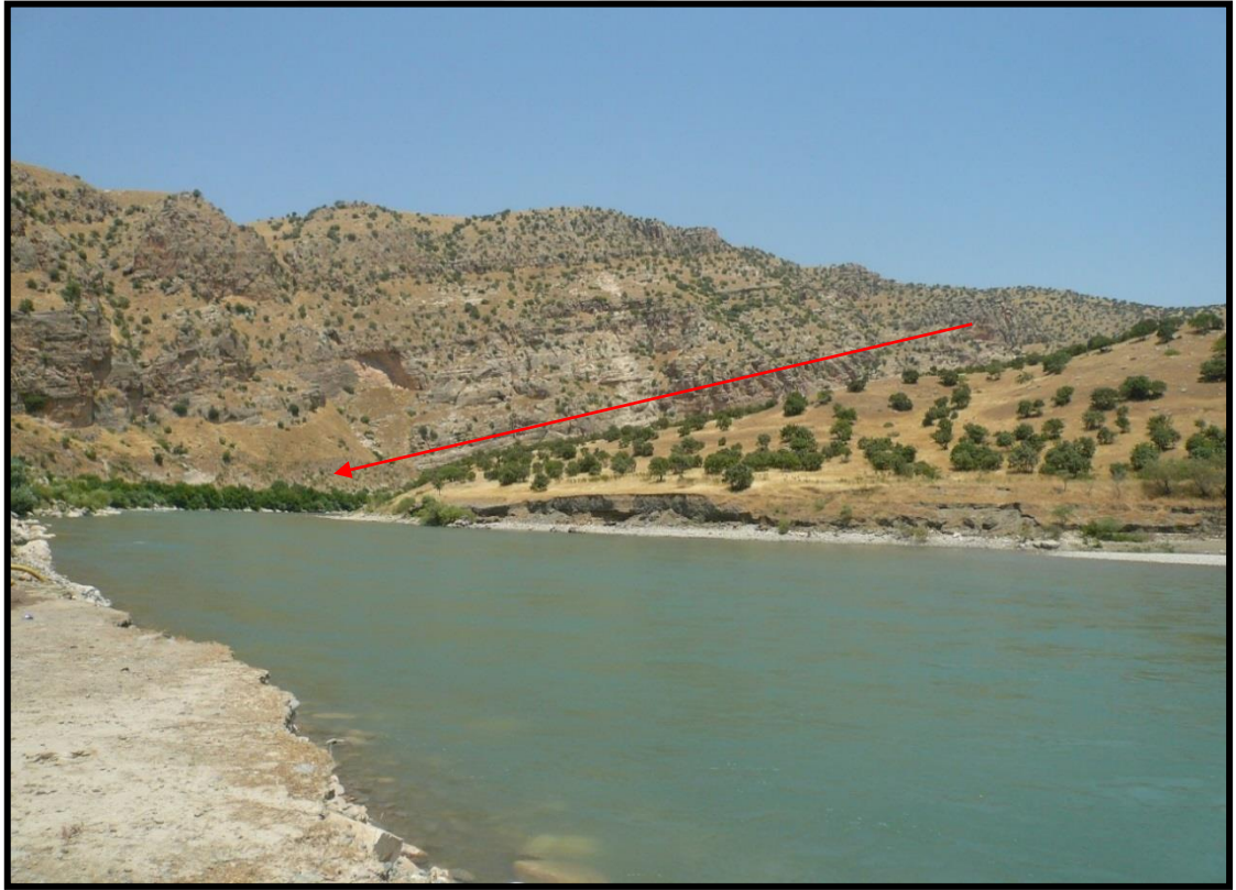
Fotoğraf 34: Siirt Merkez İlçesinde Sağlarca Köyü Civarında Görülen Düşey Atımlı Fayın Arazi Üzerindeki Görünümü.
