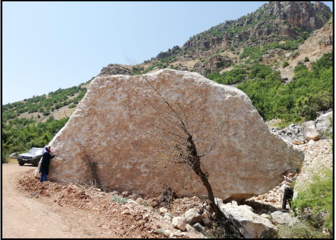
Fotoğraf 28: Tillo İlçesi Taşbalta Köyü Yolunda Düşen Bir Kaya Parçasından Görünüm.
