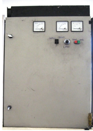
Şekil 5.4 Elektrikli dinamometre panosu.
