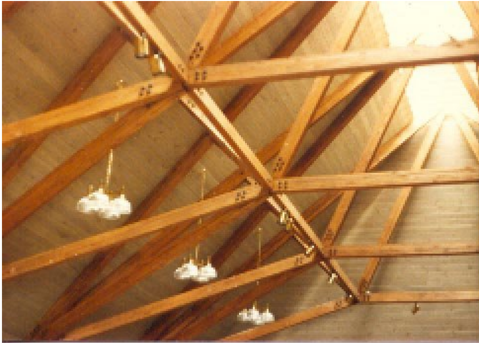
Şekil 2.2 GLULAM ile yapılmış yapı görünüşü (URL 3-2008).
