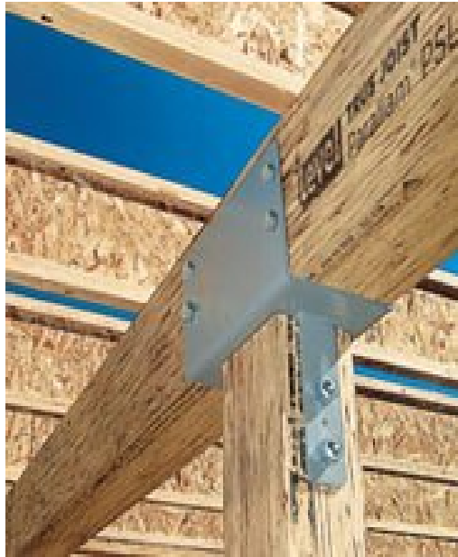
Şekil 2.3. PSL ile yapılmış yapı görünüşü verilmiştir (URL 4-2008).
