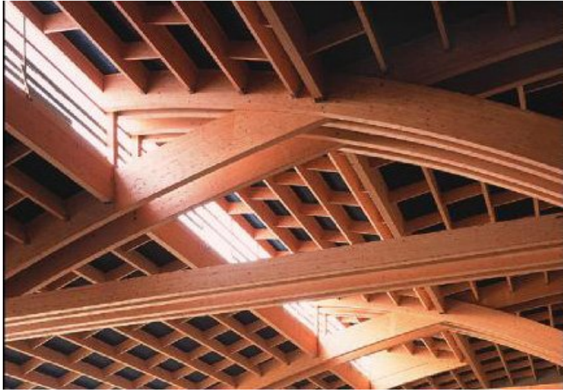
Şekil 2.10 Lamine ahşap teknolojisi (URL 7- 2008).
