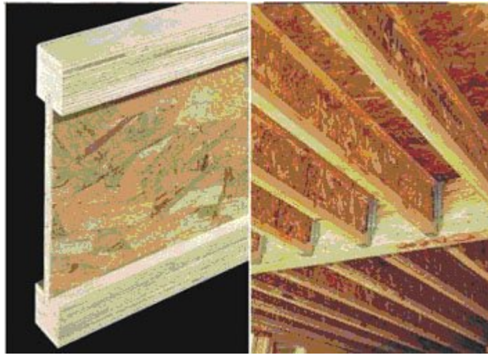
Şekil 2.9 Ahşap kompozit I-kiriş ve uygulama örneği (URL 6- 2008).
