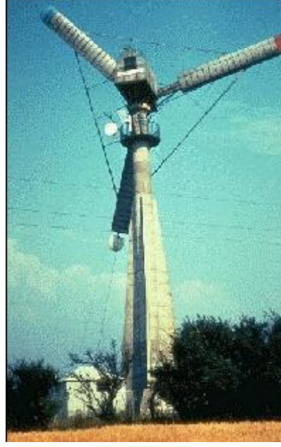
Şekil 1.1. 200 kW'lık Gedser türbini (Danimarka).
