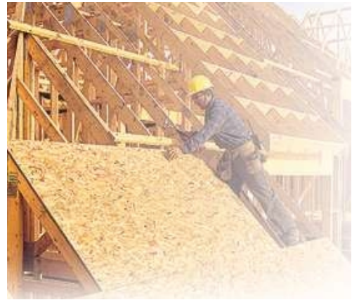
Şekil 1.25. Çatı inşasında ve izolasyonunda OSB kullanımı (Anonim, 2007).
