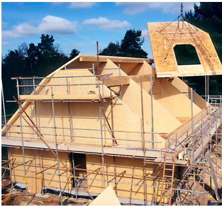
Şekil 1.25. Çatı inşasında ve izolasyonunda OSB kullanımı (Anonim, 2007).
