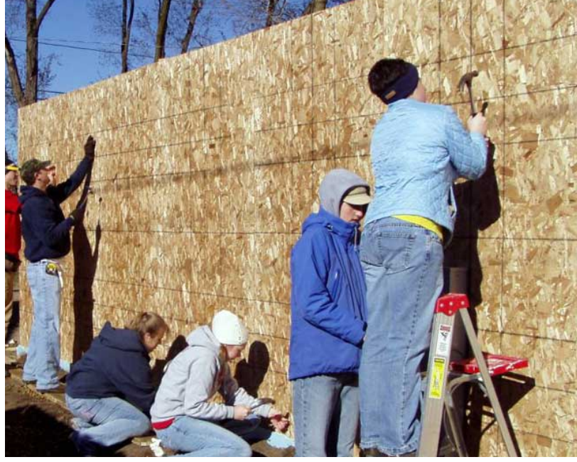
Şekil 1.26. Duvar kaplamasında OSB levha kullanımı (Anonim, 2007).
