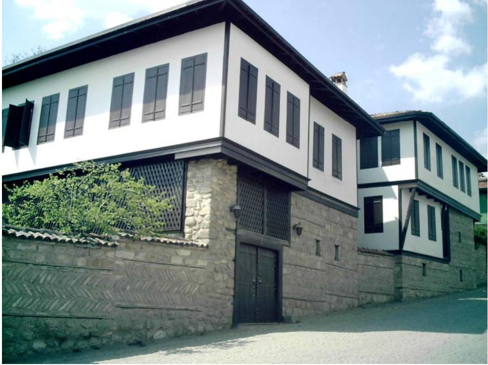
Şekil 4.6 Safranbolu evinin sokaktan dış cephe görünüşü
