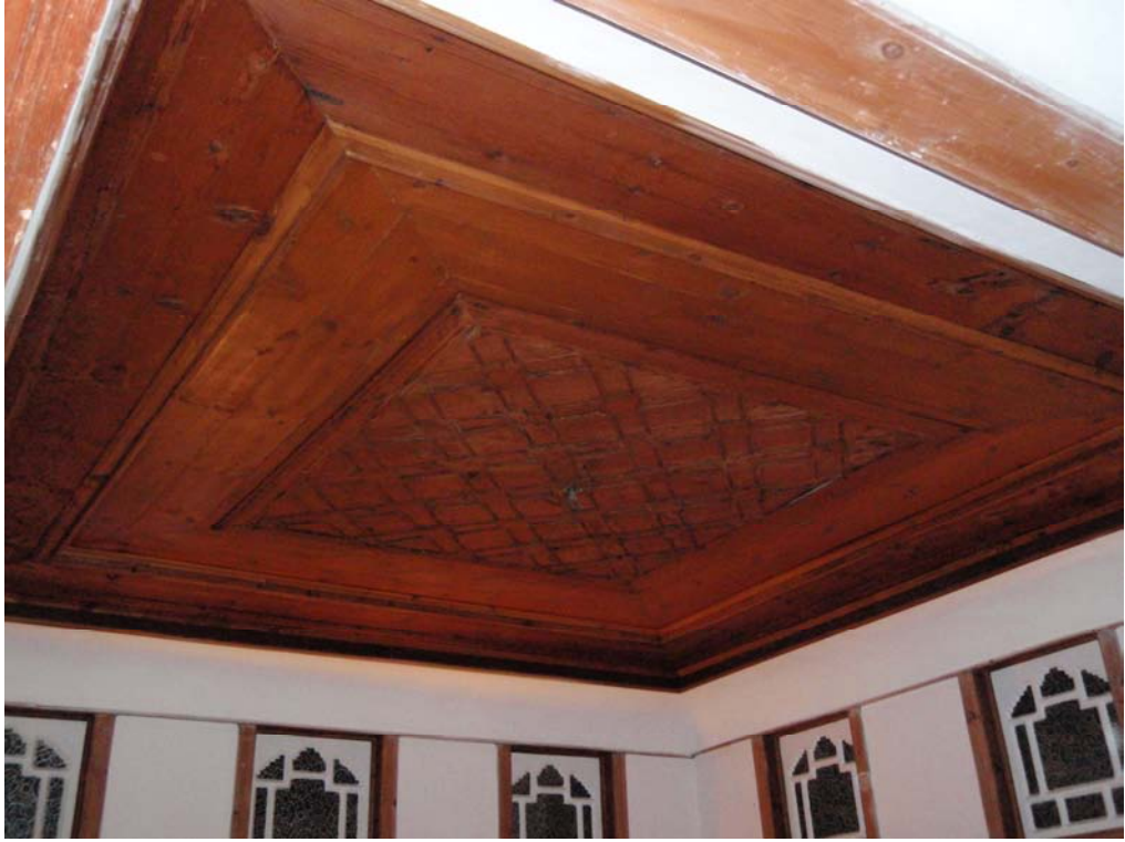
Şekil 4. 10. İşlenmiş ahşap tavan döşemesi (Asmazlar bağ evi)
