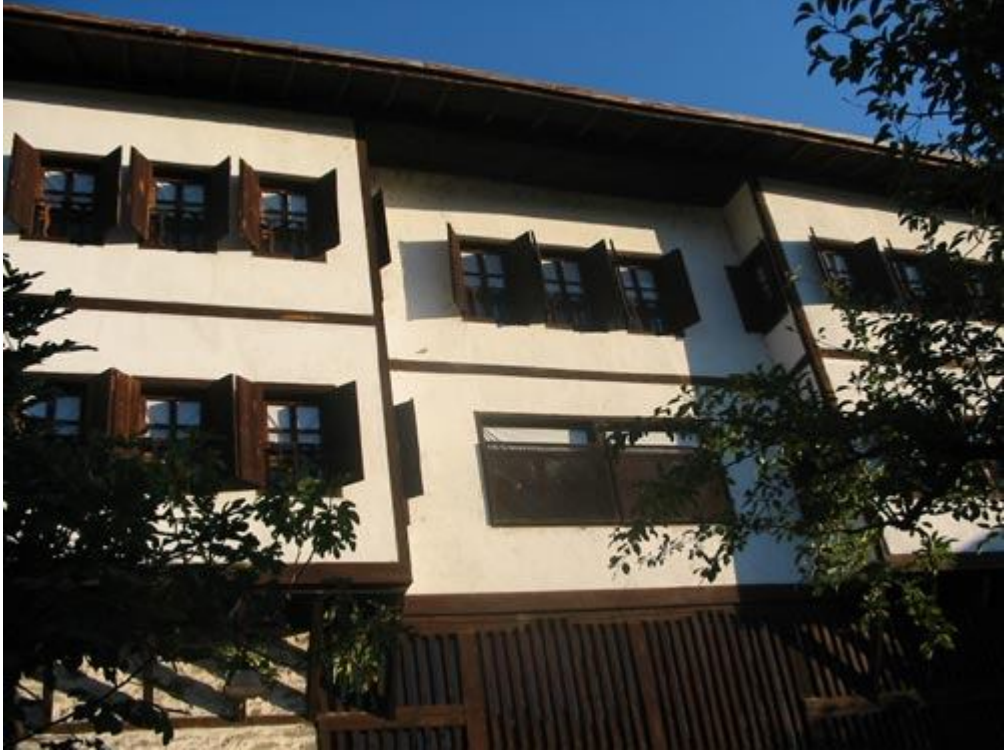
Şekil 4.5 Safranbolu evinin sokaktan dış cephe görünüşü
