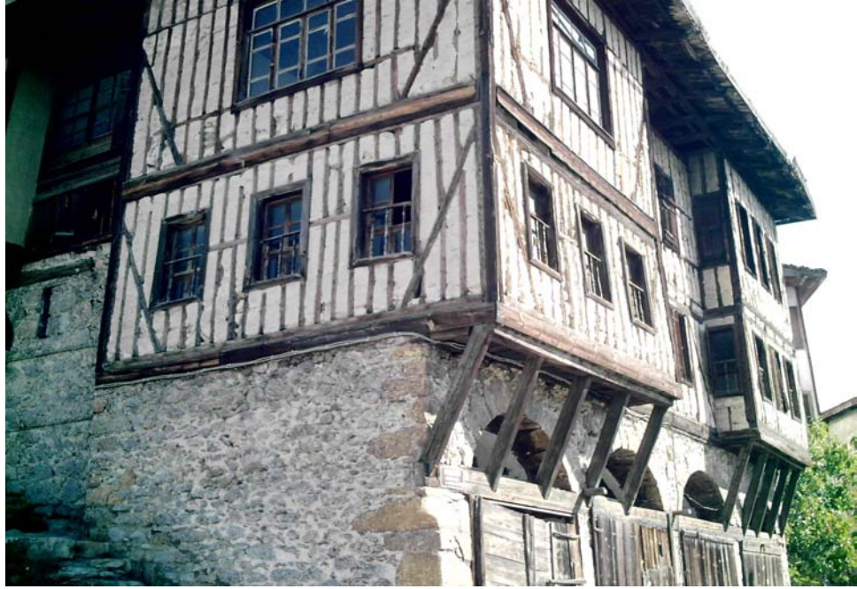
Şekil 4.4. Ahşap elemanlı Safranbolu evi
