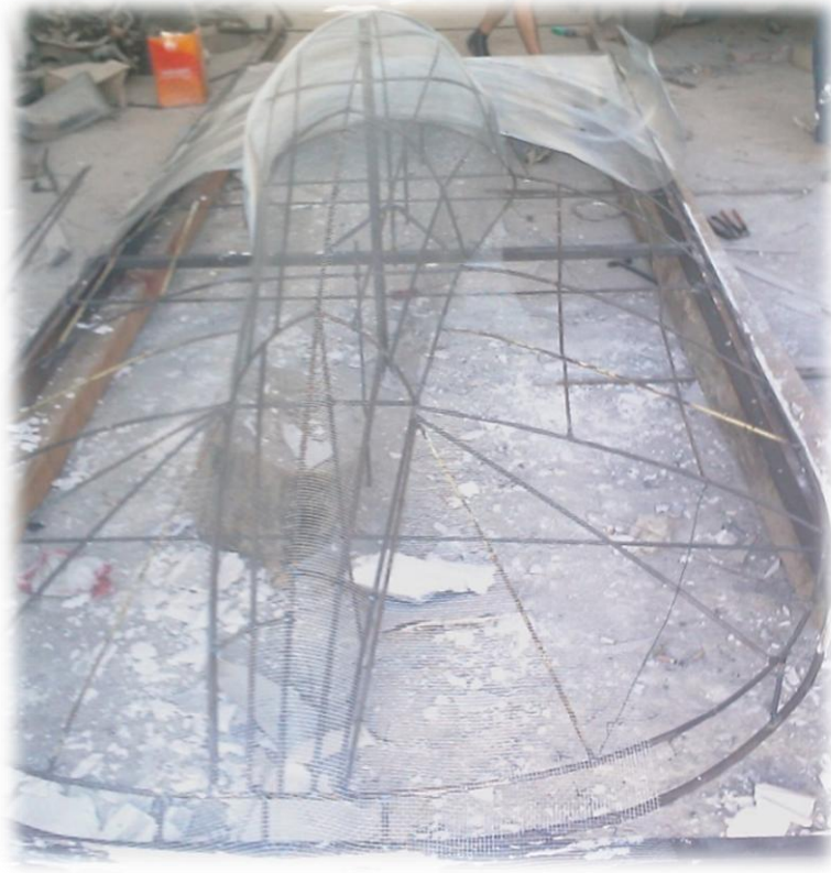
Şekil 3.7. Üst Kabuk Kalıbı İmalatı.
