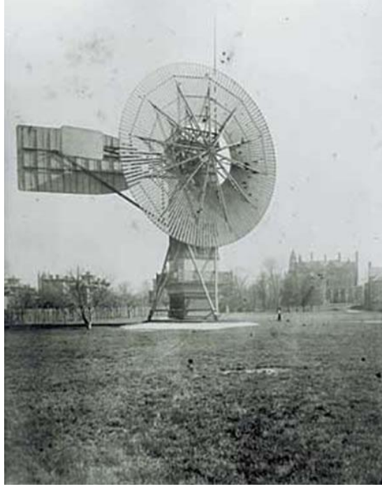
Şekil 2.2. İlk elektrik üreten rüzgar türbini ( http://www.windpower.org/en/pictures/brush.htm , 2005).
