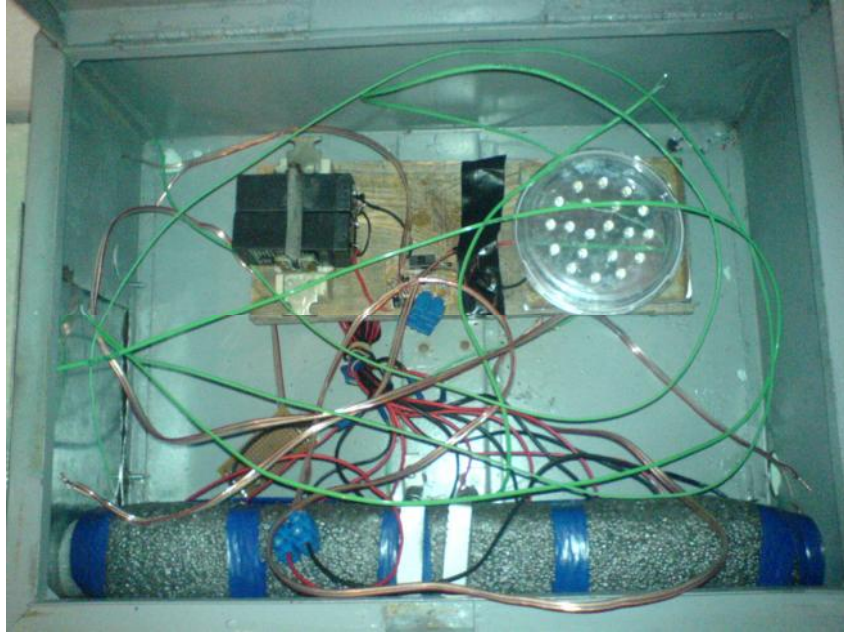
Şekil 4.6. TE jeneratörde malzemelerin kabin içerisine sabitlenmesi
