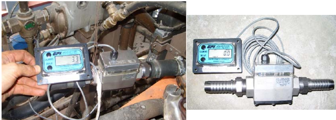
Şekil 4.9. Motor soğutma suyu debimetresi.
