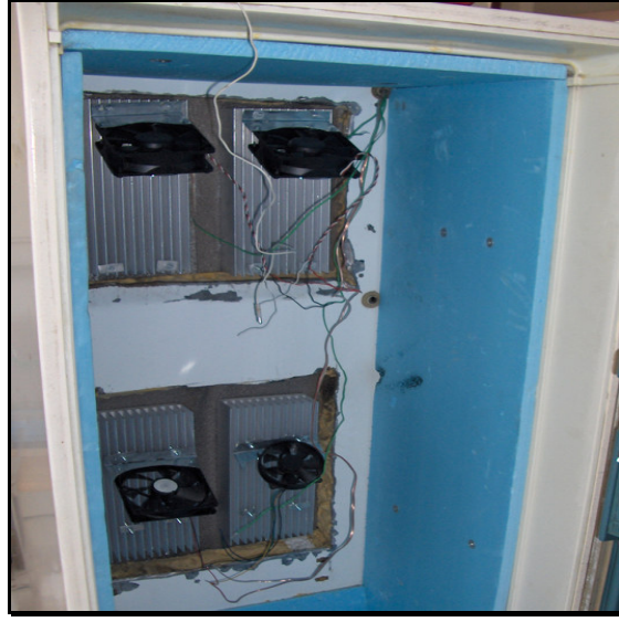
Şekil 6.10. Soğutucunun içine fanların yerleştirilmesi.
