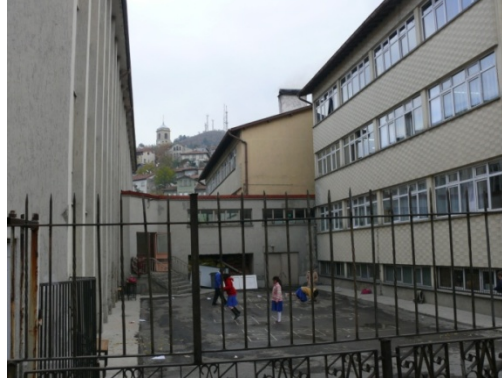
Şekil 5.31. Merkez İlköğretim Okulu yan görünüşü
