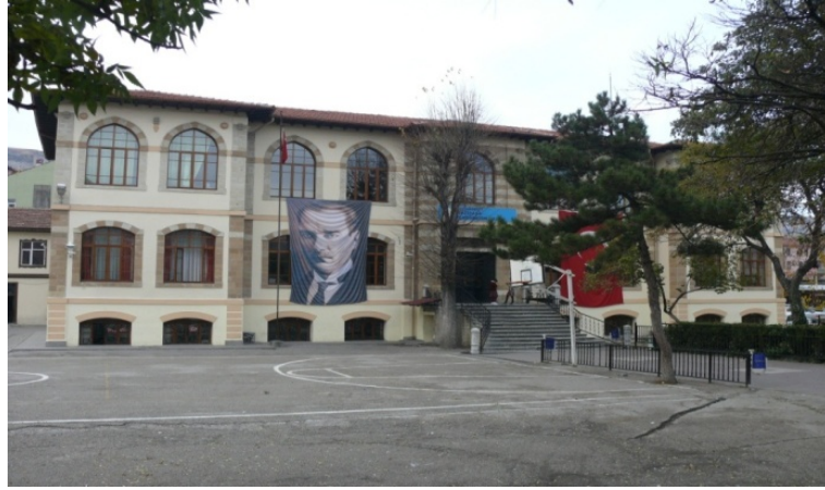
Şekil 5.2. Gazipaşa İlköğretim Okulu önden görünüşü
