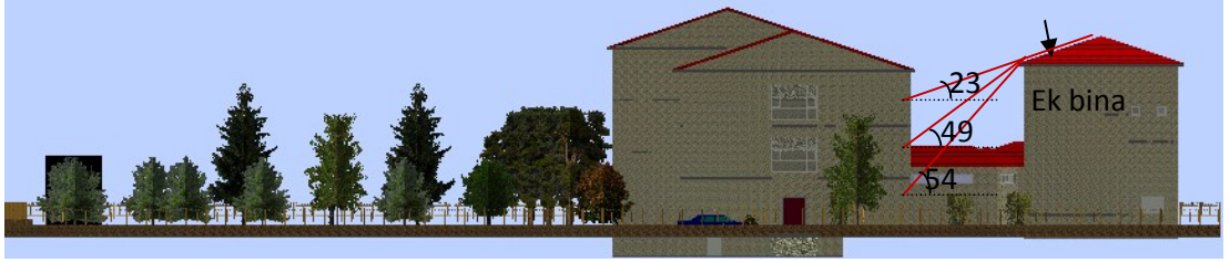
Şekil 5.39. Merkez İlköğretim Okulu ile ek binanın doğu tarafından konumu
