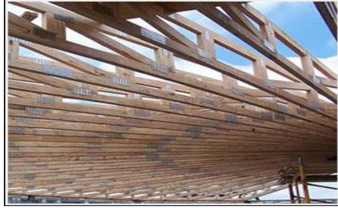
Şekil 2.1. Ahşap döşeme elemanları (kafes kiriş).
