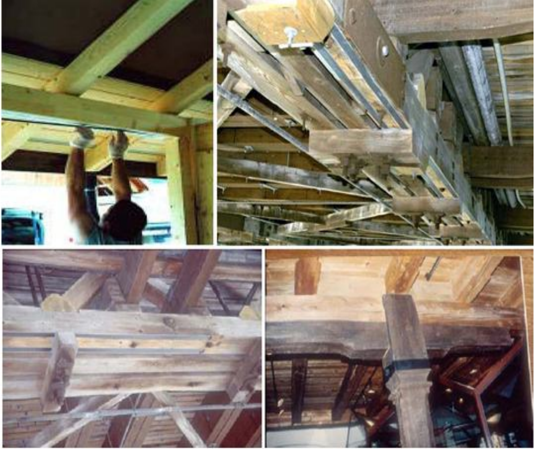
Şekil 3.10. Ahşap taşıyıcı sistemlerin CFRP'ler ile güçlendirilmesi (Steiger, 2003).
