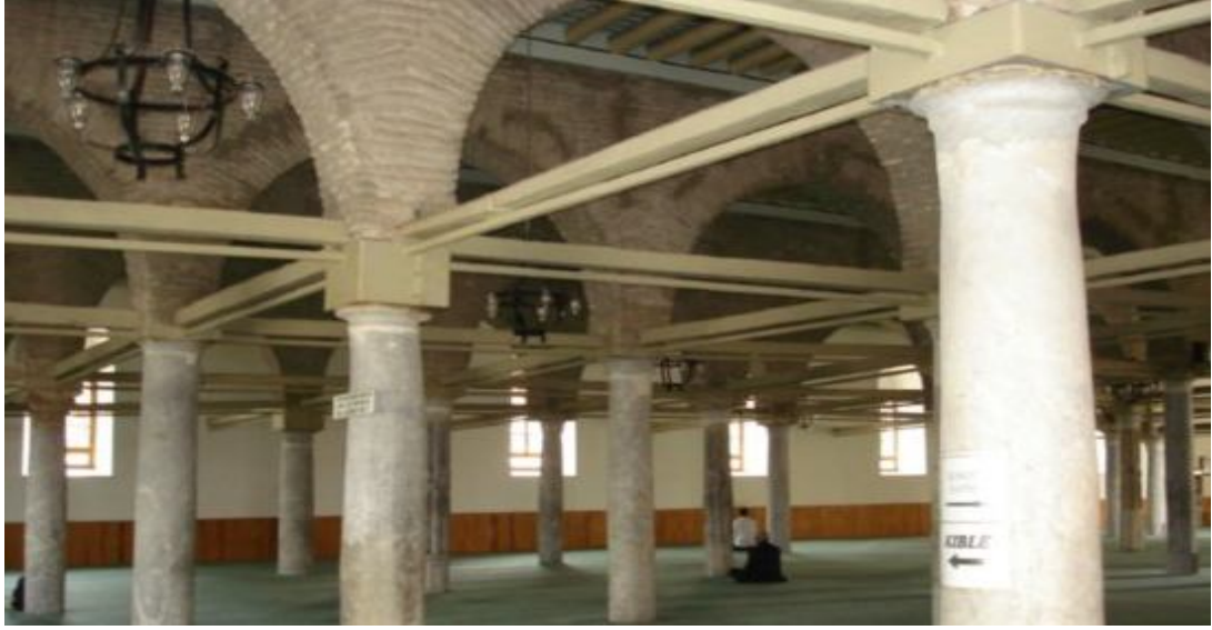
Şekil 1.1. Konya Alaaddin Camii sütun atkılarında yapılan restorasyon çalışması.
