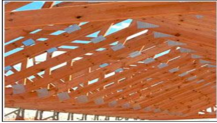
Şekil 2.3. Ahşap çatı elemanları.
