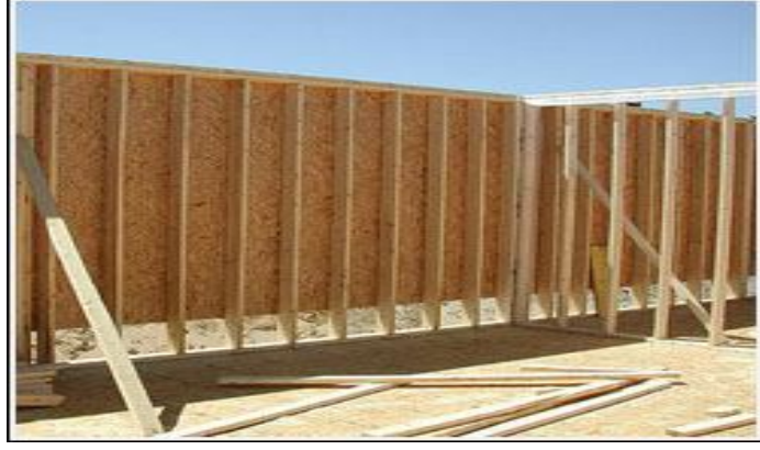
Şekil 2.2. Ahşap duvar elemanları.
