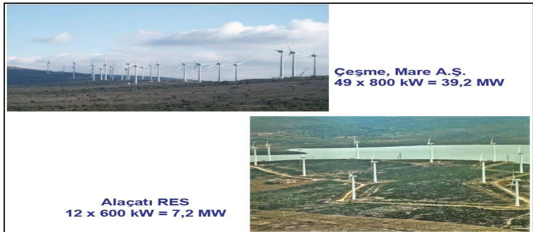
Şekil 2.5. Çeşme-Alaçatı’da kurulan rüzgar santrali [20].
