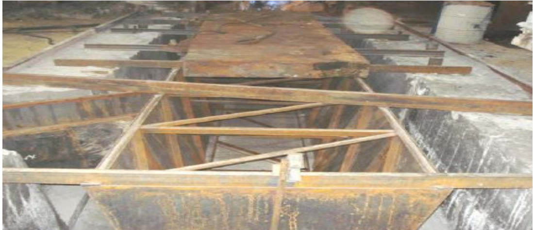
Şekil 4.10. Çalışma astarı betonu için hazırlanmış olan YF kanalı [47].
