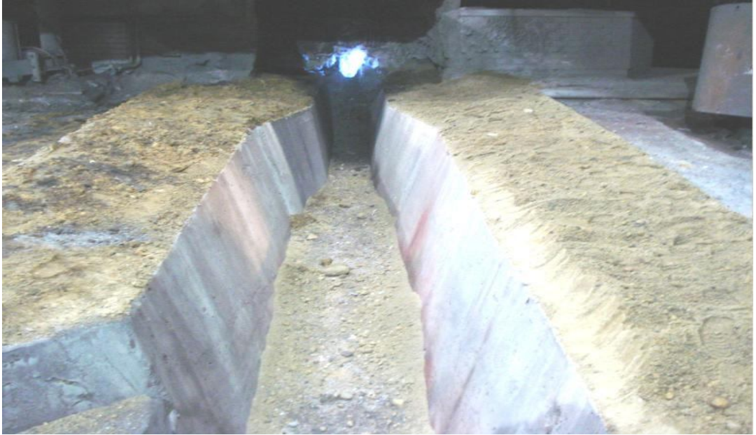
Şekil 4.12. Çalışma astarı betonu dökülmüş YF ana maden kanalı [47].
