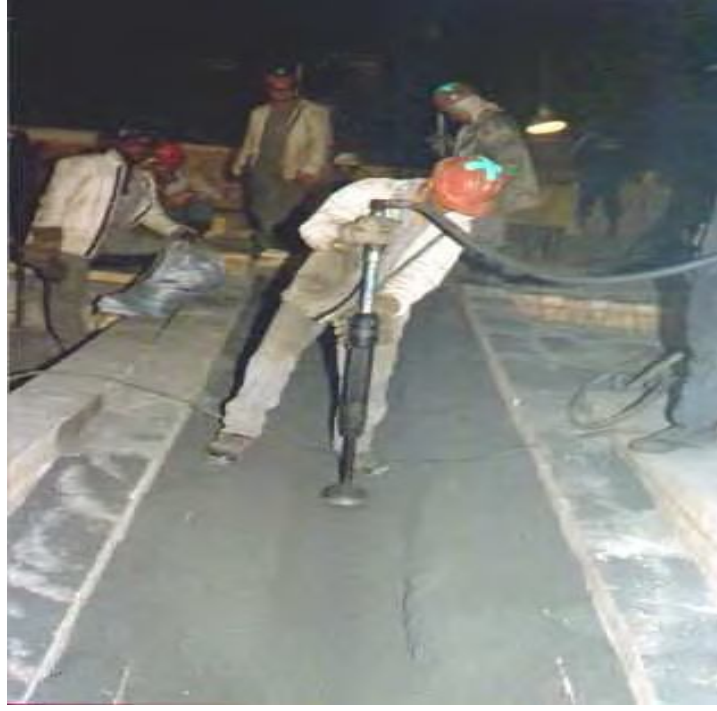
Şekil 4.7. ASC kanal dövme malzemesinin uygulanması [47].
