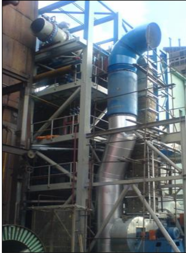
Şekil 2.7. Vantilatörün genel resmi ve emiş borusu.
