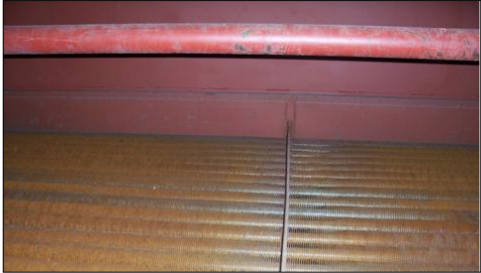
Şekil 2.11. Kızdırıcıların kazan üzerindeki genel görünüşü.
