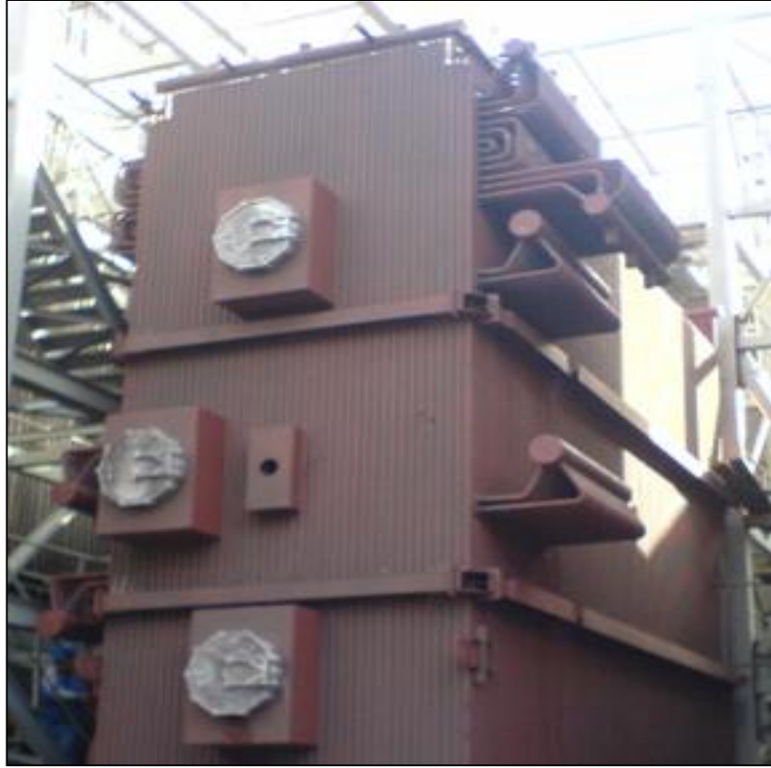
Şekil 2.14. Ekonomizerin kazan üzerindeki genel görünüşü.
