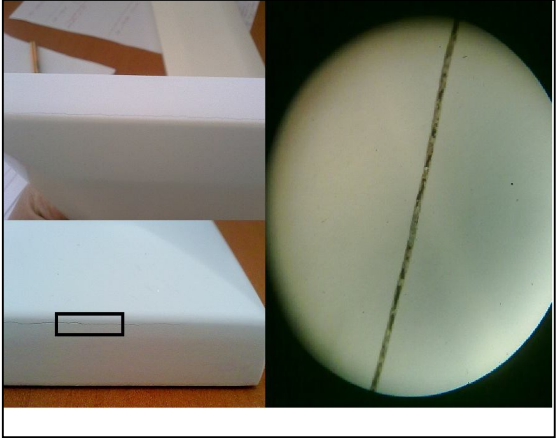
Őekil 3.18. Polyester astarlı örneklerde görülen çatlaklar.
