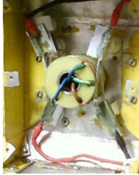
b) Fırçaların kanala yerleşmesi.
