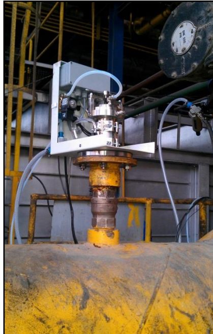
Şekil 3.9. HD probe montaj yapılmış hali.
