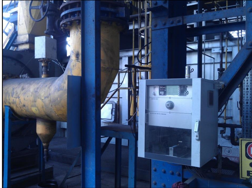
Şekil 3.6. Gaz analizör cihazının genel yerleşim şekli.
