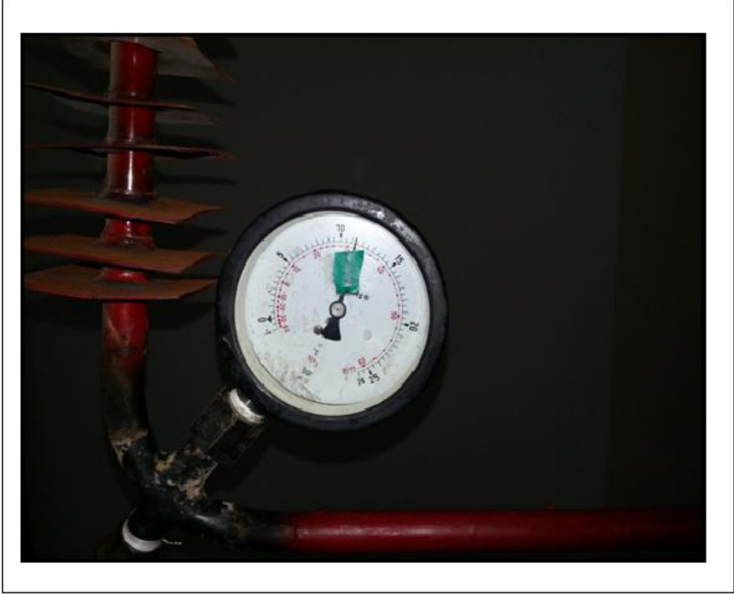
Şekil 5.6. YSS sisteminin basıncını ölçmek için sistem üzerine takılmış manometre.
