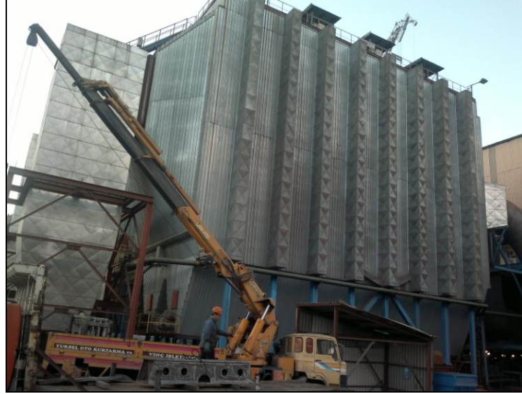
Şekil 2.12. Elektro speküler partikül tutucu.
