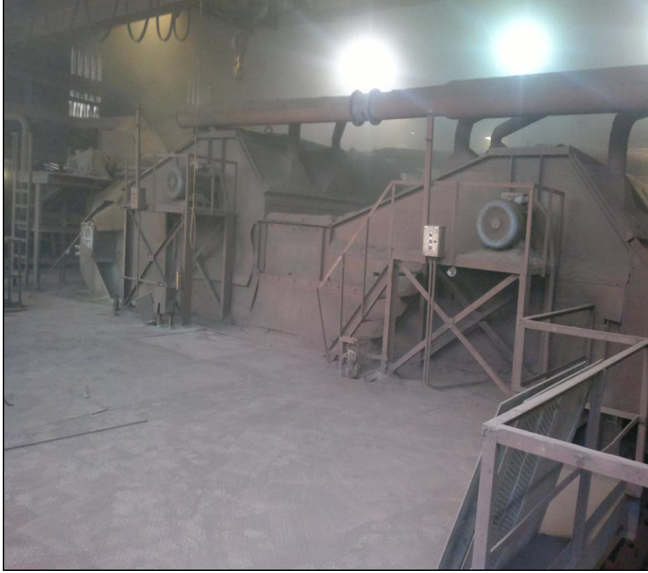
Şekil 2.11. Sinter dozajlama binası.
