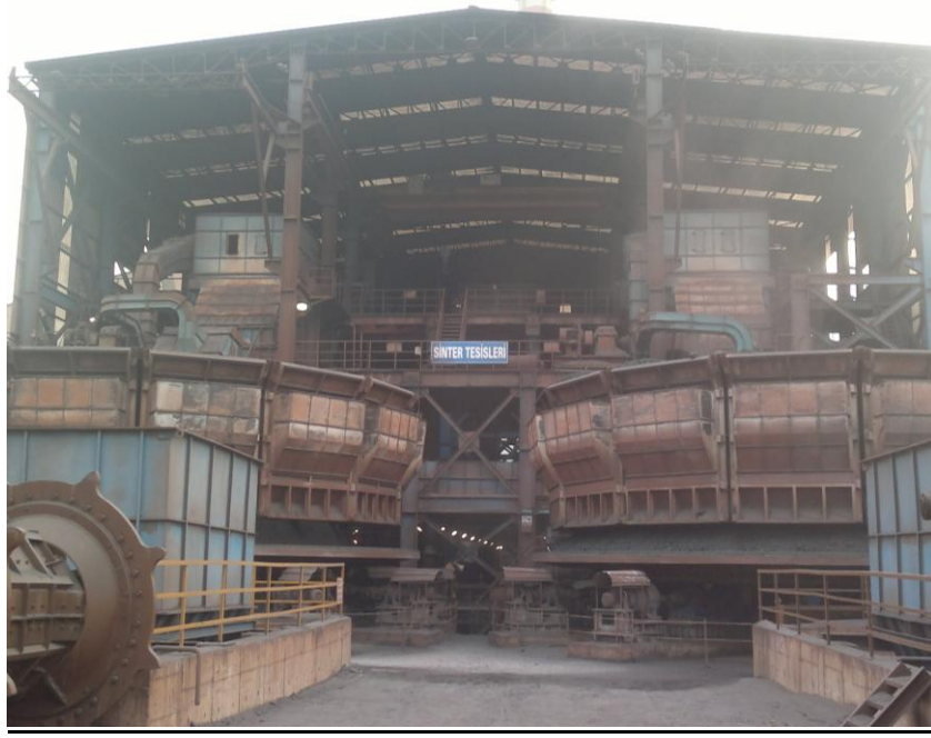
Şekil 2.6. Sinter Tesisi genel görünüş resim.
