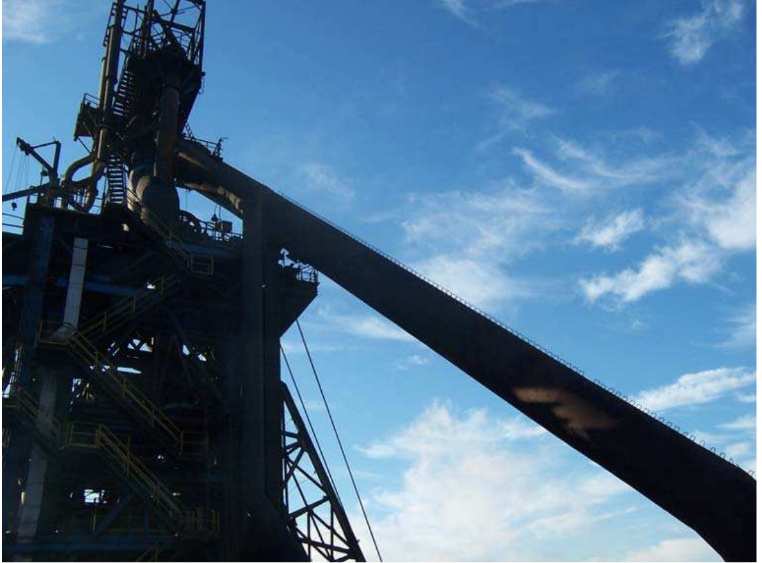
řekil 5.8. Yüksek Fırınlar baca gazı (YFG) toplama sistemi ve ana toplayıcı boru.
