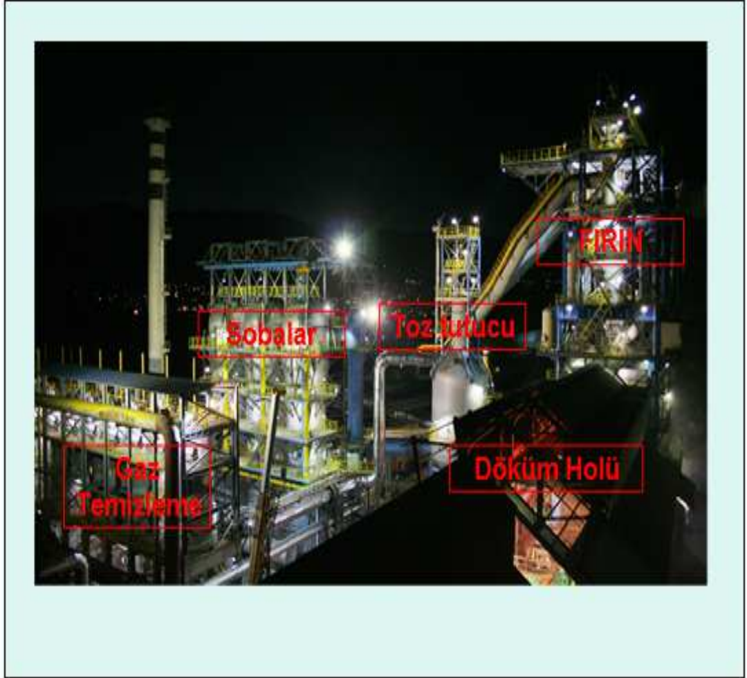
Şekil 4.1. Kardemir A.Ş. 4 no'lu yüksek fırını ve yardımcı tesisleri.
