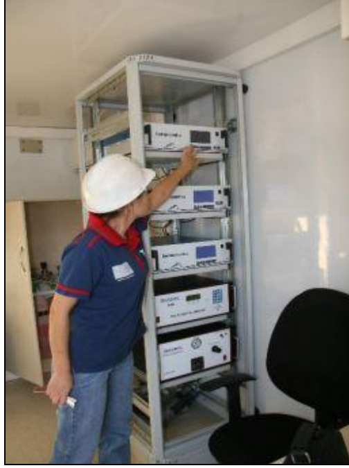
Şekil 5.2. KARDEMİR hava kalitesi ölçüm laboratuvarı iç görünüm.
