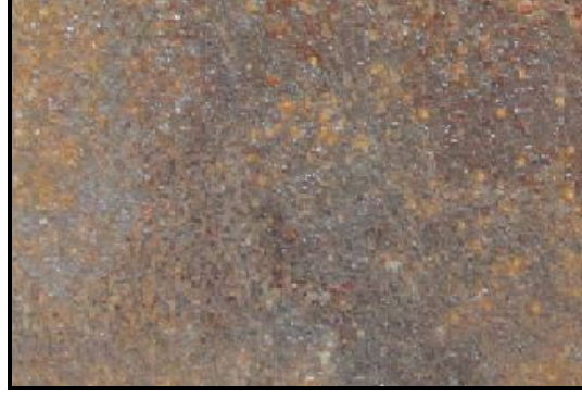
Şekil 4.5. Yüzeyi paslanmış numune görüntüsü.
