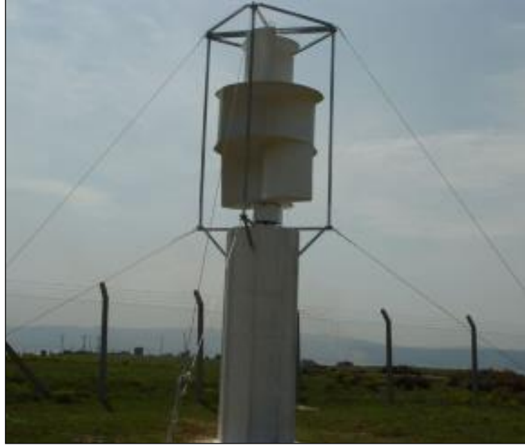
Şekil 2.2. Üç katlı savonius rüzgâr türbini [38].
