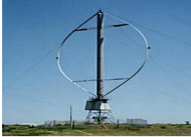
Şekil 2.3. Rüzgârı arkadan alan rüzgar türbini.
