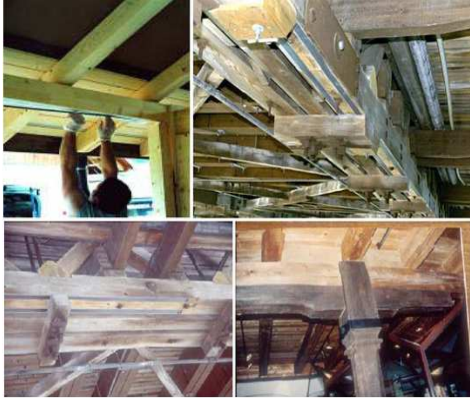
Şekil 3.19. Ahşap taşıyıcı sistemlerin CFRP'ler ile güçlendirilmesi (Steiger, 2003).
