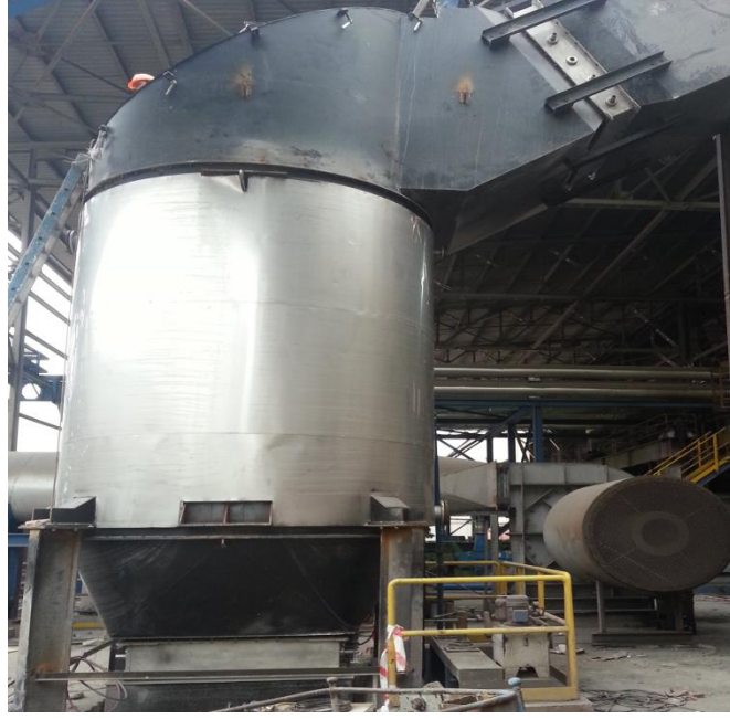
Şekil 3.14. Atık ısı kazanı.
