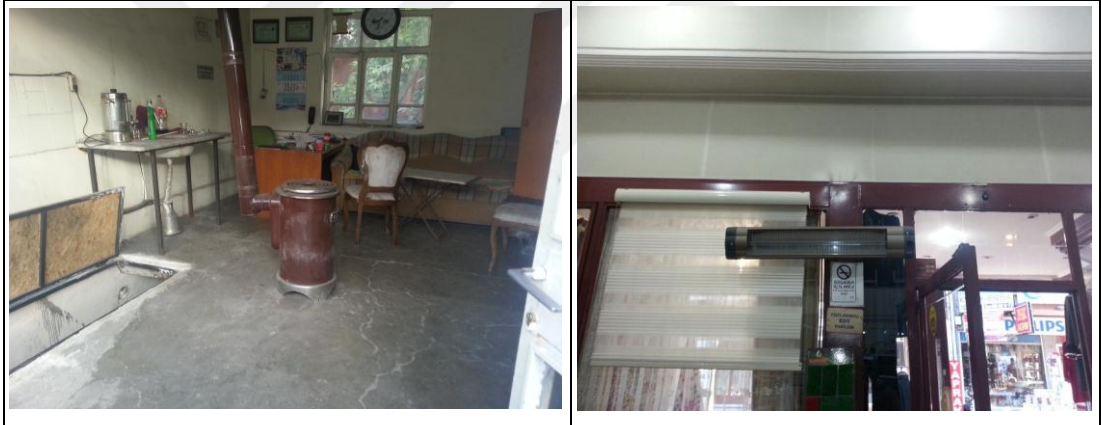
Şekil 5.56. Çankırı geleneksel alışveriş alanındaki dükkanların ısıtma sistemi.
