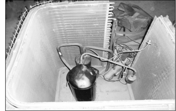
Şekil 3.3. Dış ünitenin iç görünüşü.
