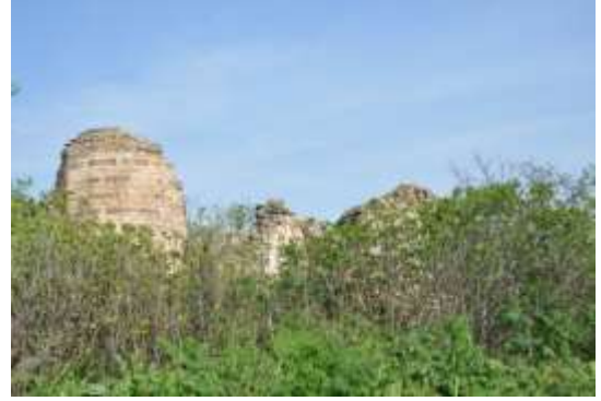
Şekil 3.33. Caminin bir kısmı yıkılan minaresi.
