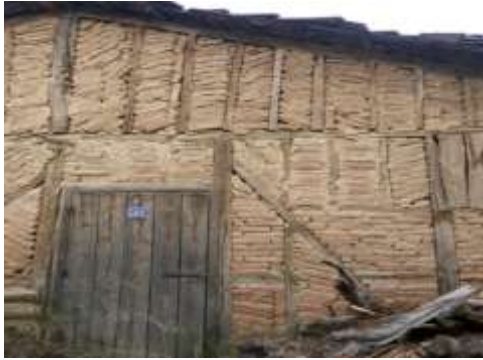
Şekil 3.138. Ahşap çatkılı kerpiç dolgu sistem samanlık.
