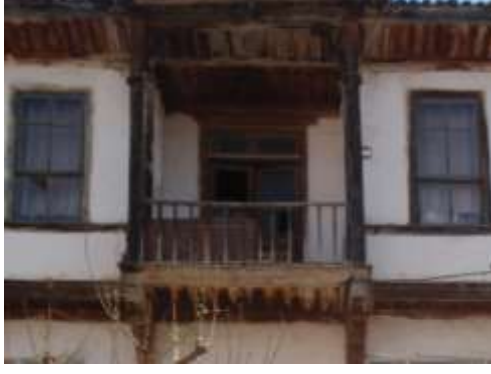
Şekil 3.132. Tescilsiz yapı balkon.
