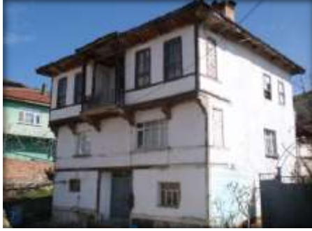
Şekil 3.128. Tescilsiz yapı cumba.
