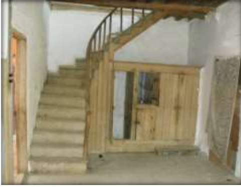
Şekil 3.105. Ahşap merdiven envanter no:12.
