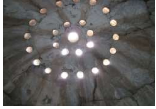
Şekil 3.37. İç mekandan kubbe görüntüsü.
