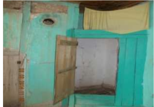
Şekil 3.147. Ocağın kapatılıp yüklük olarak kullanılması.
