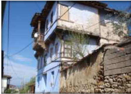
Şekil 3.86. Güçlü bir sınır oluşturan bahçe duvarı.
