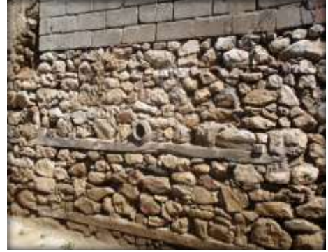
Şekil 3.137. Yığma moloz taş duvar.
