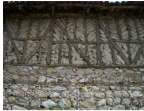
Şekil 3.139. Ahşap çatkılı yığma moloz taş duvar sistemi.
