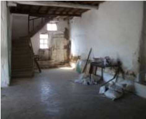
Şekil 3.94. Tescilsiz yapı zemin kat.
