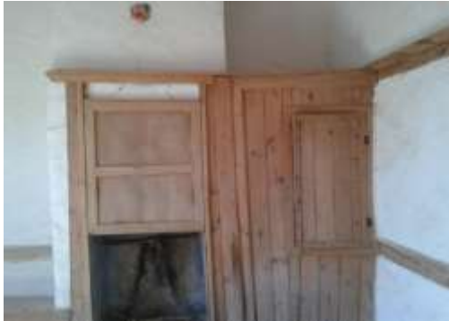
Şekil 3.146. Ocağın kapatılıp yüklük olarak kullanılması.
