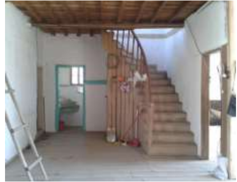
Şekil 3.108. Ahşap merdiven envanter no:5.
