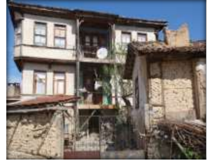
Şekil 3.85. Bahçe yol cephesinde yapı arka tarafa inşa edilmiş.
