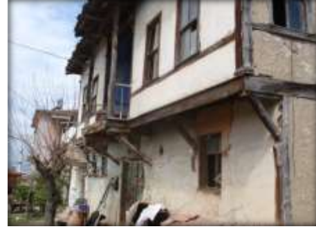
Şekil 3.129. Tescilsiz yapı cumba.
