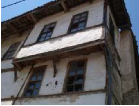
Şekil 3.130. Tescilsiz yapı cumba.
