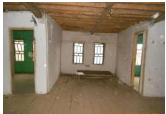
Şekil 3.104. Ahşap tavan ve yer döşemesi.
