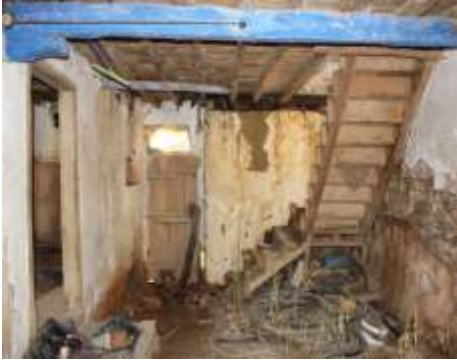
Şekil 3.90. Tescilsiz yapı bodrum kat.
