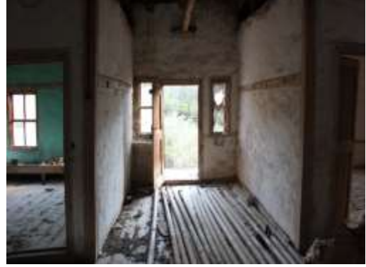
Şekil 3.93. Tescilsiz yapı zemin kat.
