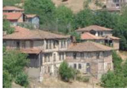
Şekil 3.5. Mecidiye köyü görünüş [135].
