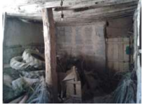
Şekil 3.89. Tescilsiz yapı bodrum kat.
