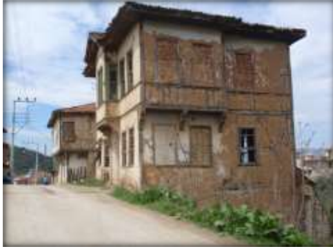
Şekil 3.136. Kerpiç yapı malzemesi envanter no:12.
