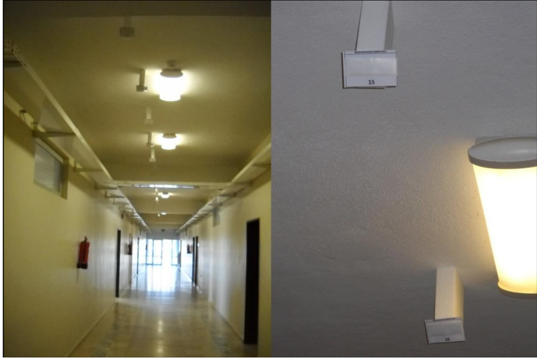
Şekil 5.2. Taşıyıcılar tavana yapıştırılmış vaziyette koridor görüntüsü.
