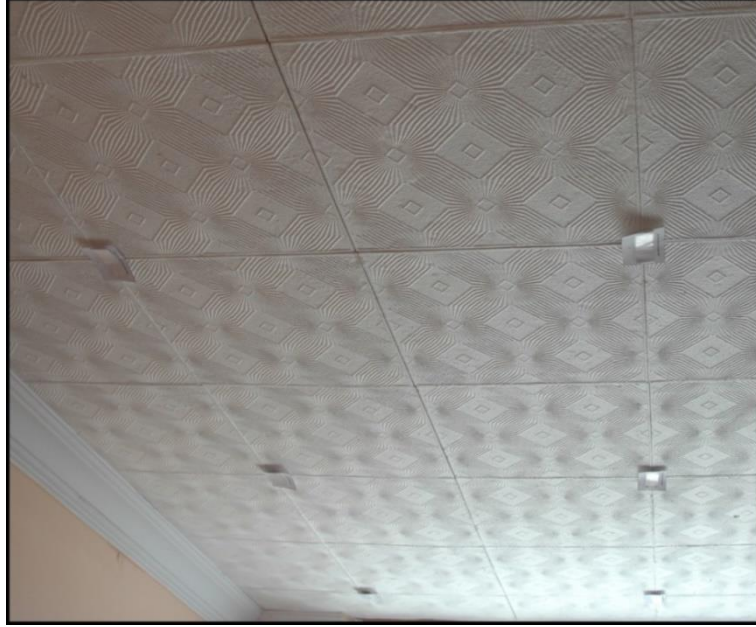
Şekil 5.17. Taşıyıcıların yapıştırıldığı tavan yüzeyi.
