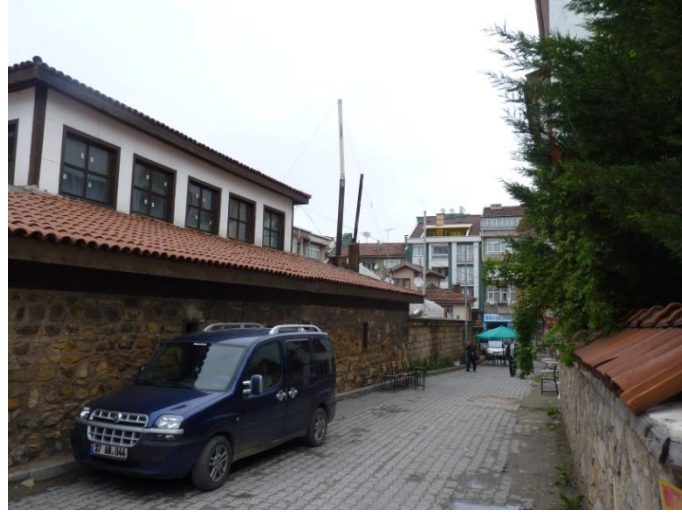
Şekil 3.26. Bey Hamamı sağ yan cephesi [9].
