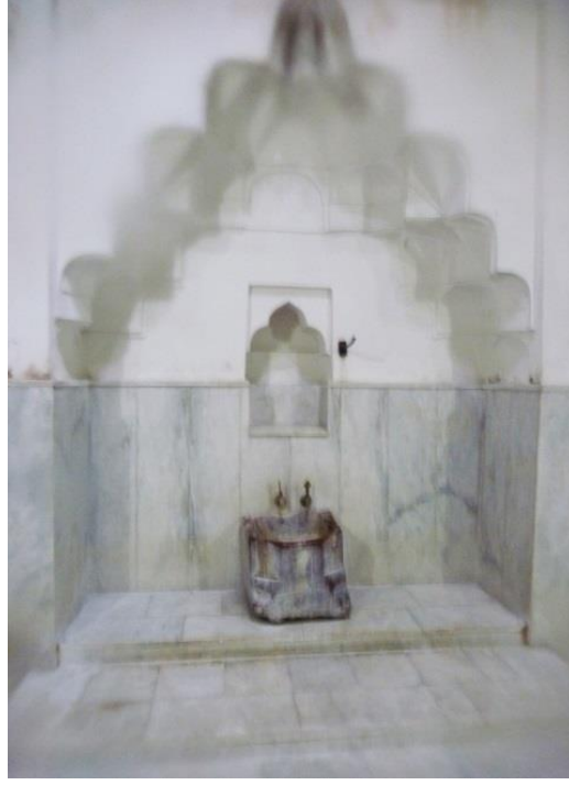
Şekil 3.63. Arabapazarı Hamamı duvardaki nişler [9].
