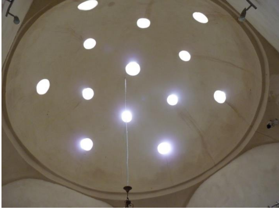
Şekil 3.44. Saray Hamamı sıcaklık mekânı tavanı [9].
