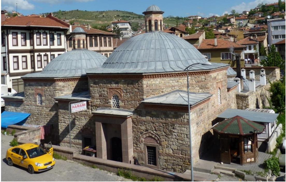
Şekil 3.65. Arabapazarı Hamamı güney cephesi [9].
