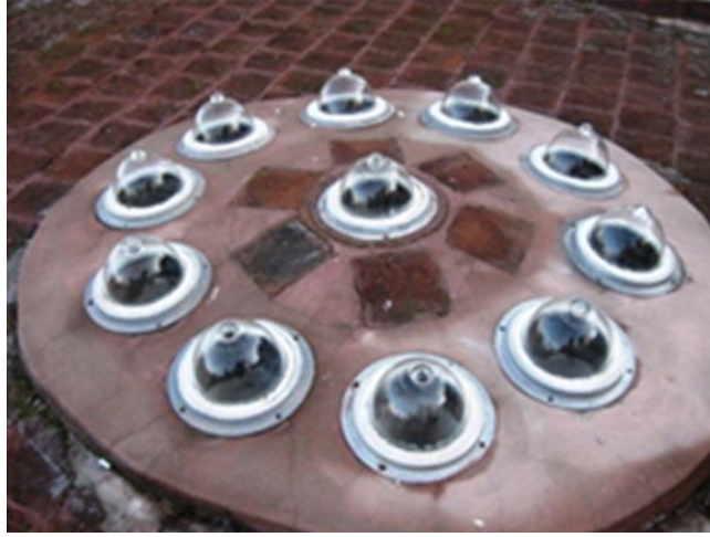
Şekil 2.29. Safranbolu Eski Rum Hamamı Kubbesindeki Fil gözü aydınlatma [30].
