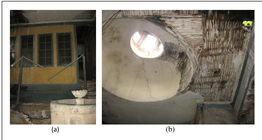
Şekil 3.27. Kale Hamamı a) soyunmalık mekânı süs havuzu, b) çatı feneri [9].
