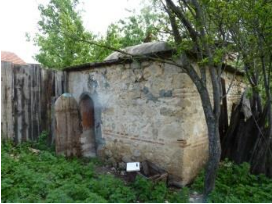
Şekil 3.82. Balabanağa Konağı Hamamı ön cephesi [9].
