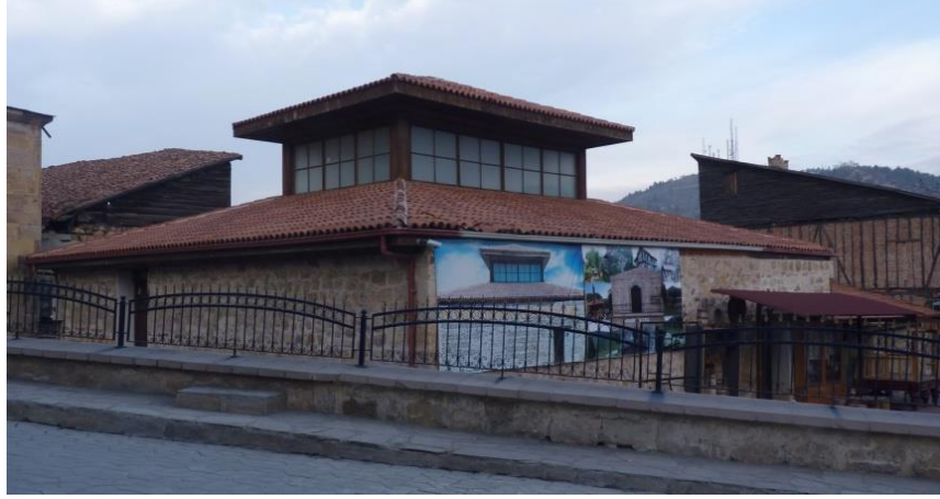
Şekil 3.8. Vakıf Hamamı ön cephesi [9].
