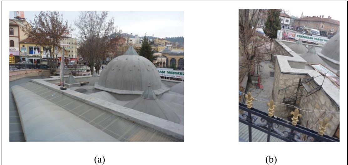
Şekil 3.15. Frenkşah Hamamı a) çatı görünüşleri, b) sağ yan cephesi [9].
