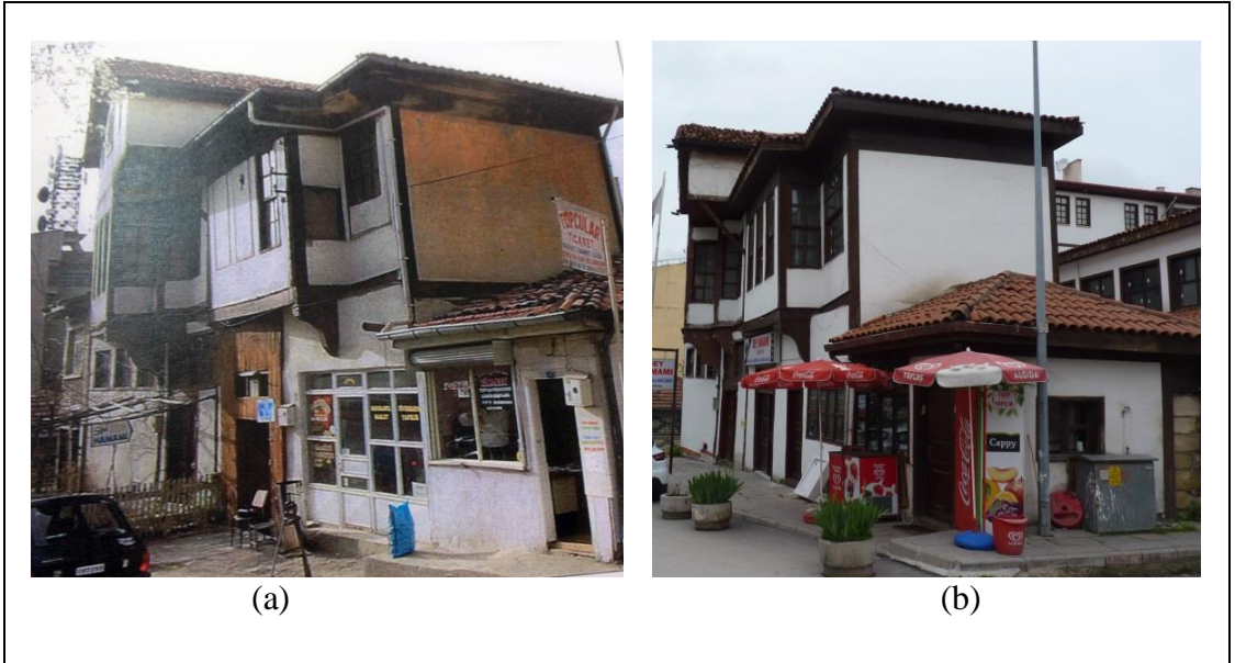
Şekil 3.25. Bey Hamamı girişi a) restorasyon öncesi, b) restorasyon sonrası [9-36].
