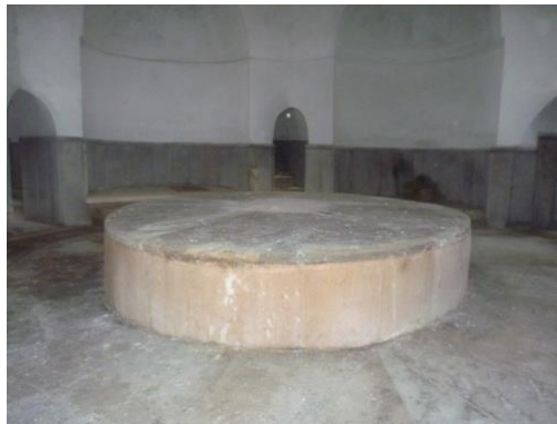
Şekil 3.6. Sıcaklık mekânındaki göbek taşı [9].
