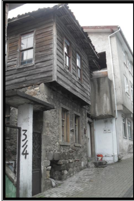
b) 1850 parsel üzerindeki konutun arka görünüşü (2011) [21].
