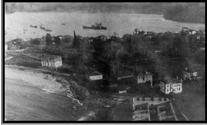
a) Bahriye Mektebi binası [6].
