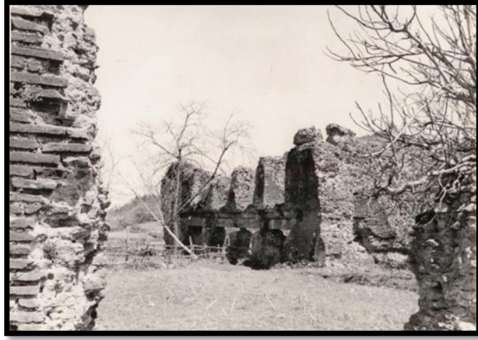
a) 1968 depremi sebebiyle yıkılmış Bedesten doğu bloğu (1953) [6].
