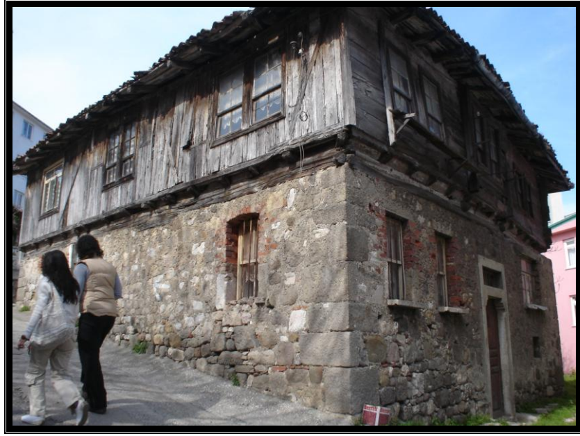
a) Boztepe’de 1794 parsel üzerindeki konutun onarım öncesi hali (2007) [40].
