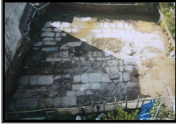
Şekil 4.16. Temel kazısı sırasında çıkan antik döşeme (2014) [40].
