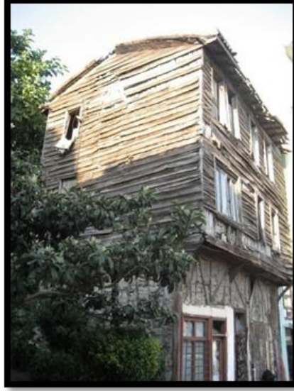
a) Onarım öncesi (2008) [40].
