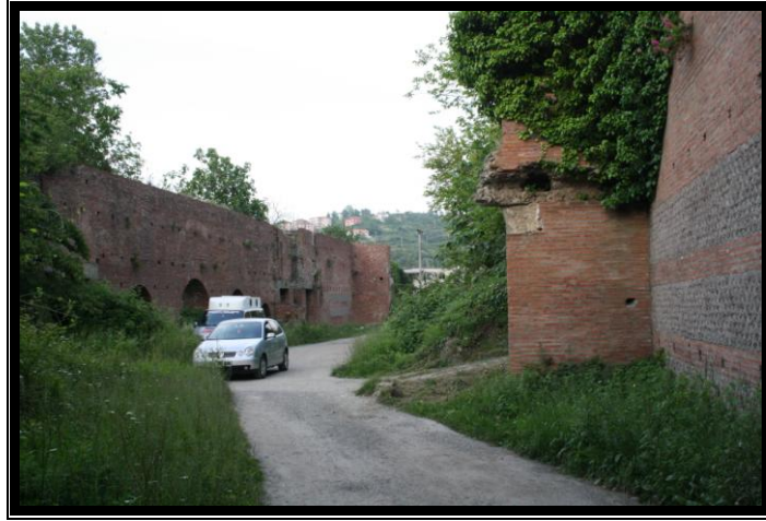
a) Bedesten ierisinden geen yol (2014) [21].
