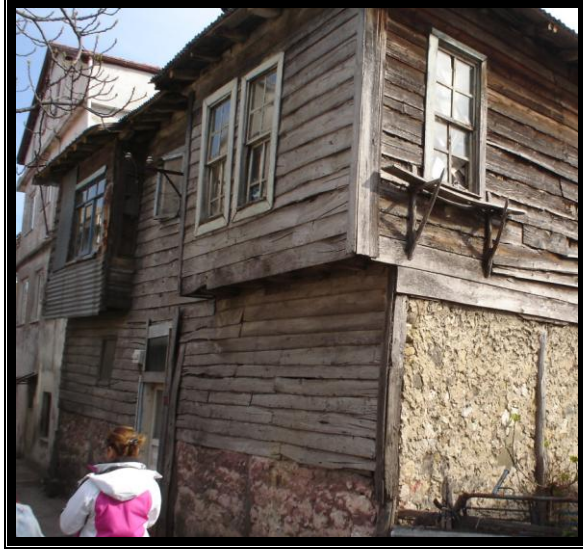
a) Onarım öncesi (2010) [21].
