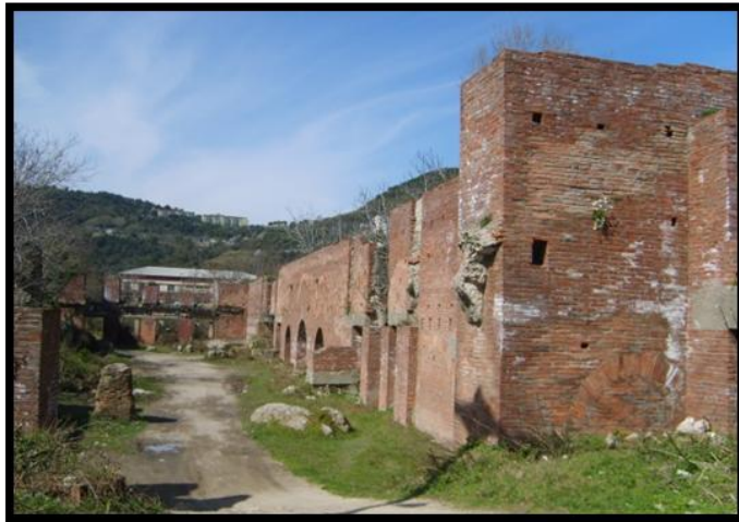
b) 2000 yılında Kültür ve Turizm Bakanlığı tarafından yapılan restorasyon sonrası yapı kalıntıları (2013) [21].
