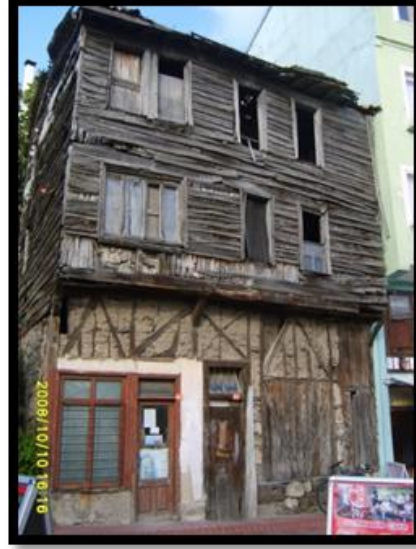
a) Onarım öncesi (2008) [40].
