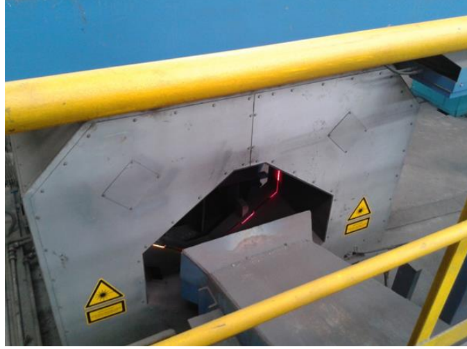
Şekil 3.1. Lazer gauge ölçü kontrol ünitesi.
