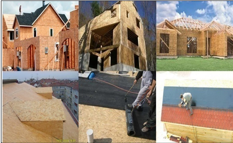
Şekil 5.1. İnşaat sektöründe OSB'nin çatı ve inşaat uygulamalarında kullanımı.
