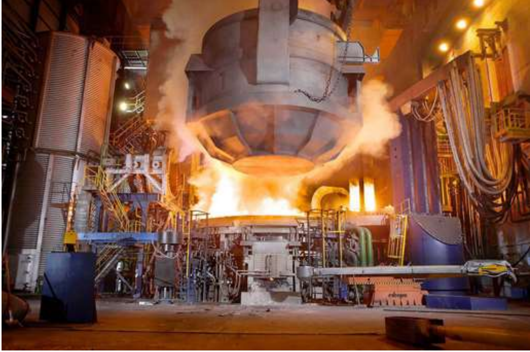
Şekil 3.1. Çolakoğlu Metalurji A.Ş elektrik ark ocağı.
