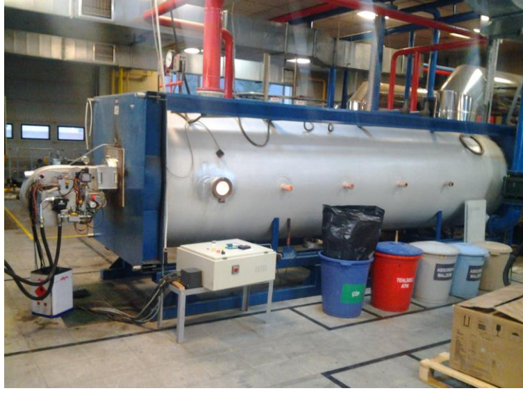
Şekil 5.42. ALF 180/M modülasyonlu brülörün kazana montajlanmış görüntüsü.
