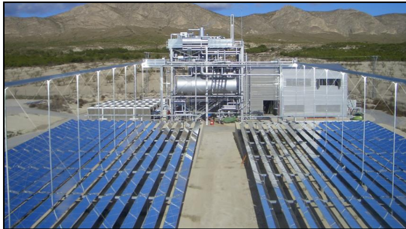
Şekil 3.4. Fresnel merceкли odaklayıcı yoğunlaştırıcılar [38].
