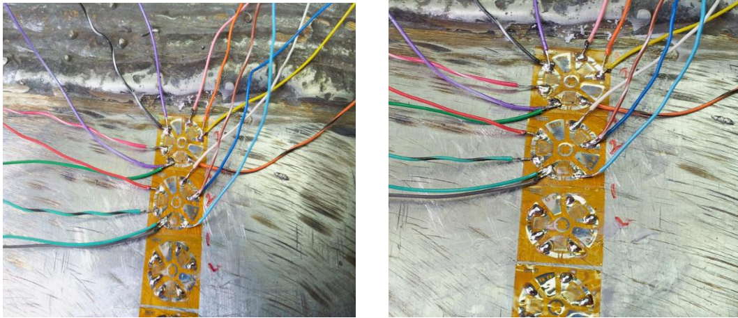
Şekil 5.9. Rozetteki gerilim ölçerlere kablo bağlantılarının görünümü.
